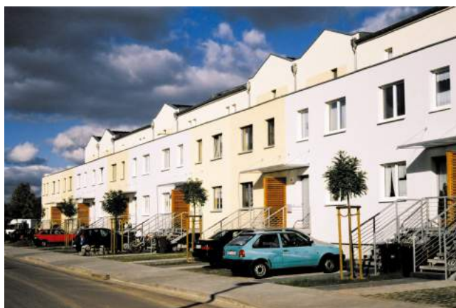
stávající stav zástavby po zásahu, demolici a přestavbě
