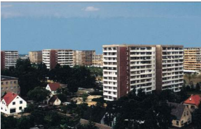
původní stav 11 podlažního panelového domu
