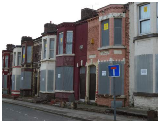
zabedněné domy v Liverpoolu čekající na demolici
