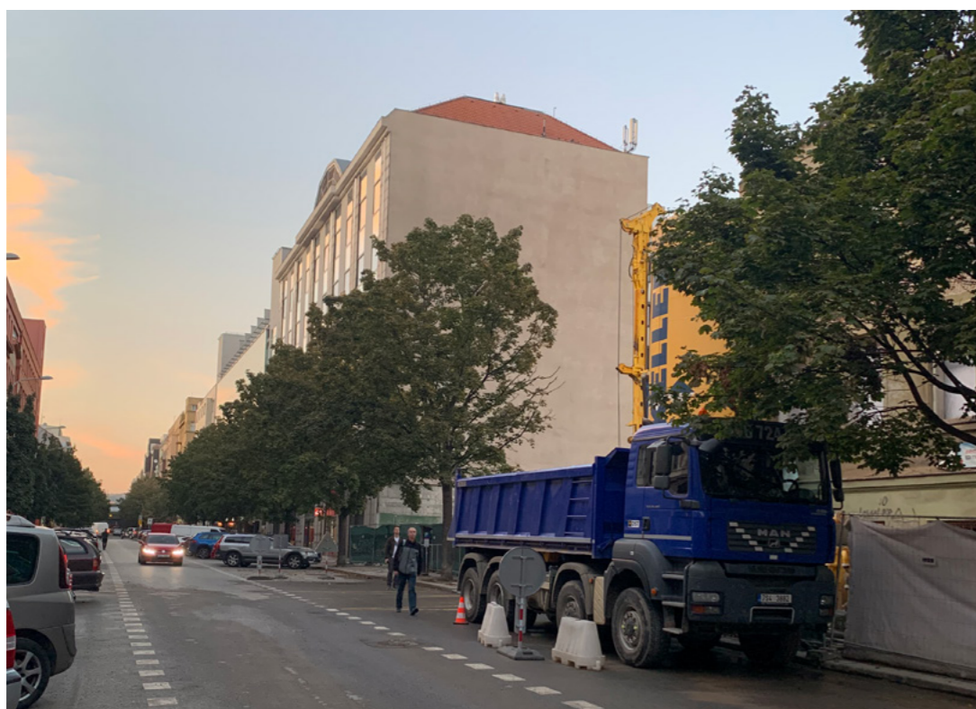
pohľad z ulice Thámova na fasádu susedného objektu
