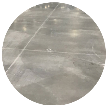
Podlaha -drátkobetonová deska leštěna
