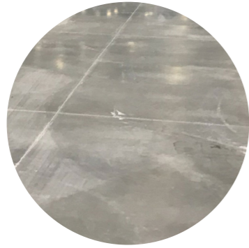
Podlaha -drátkobetonová deska leštěna
