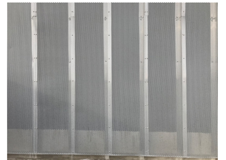
Řešení fasády OC Šestka - perforované plechy jako LOP
