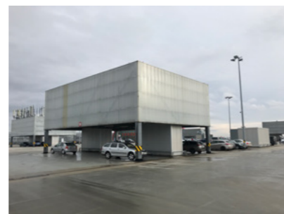
Střecha OC Šestka
