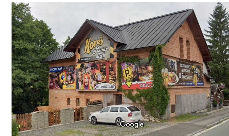
14. ukázka nevhodně provedené reklamy na fasádě místního baru
