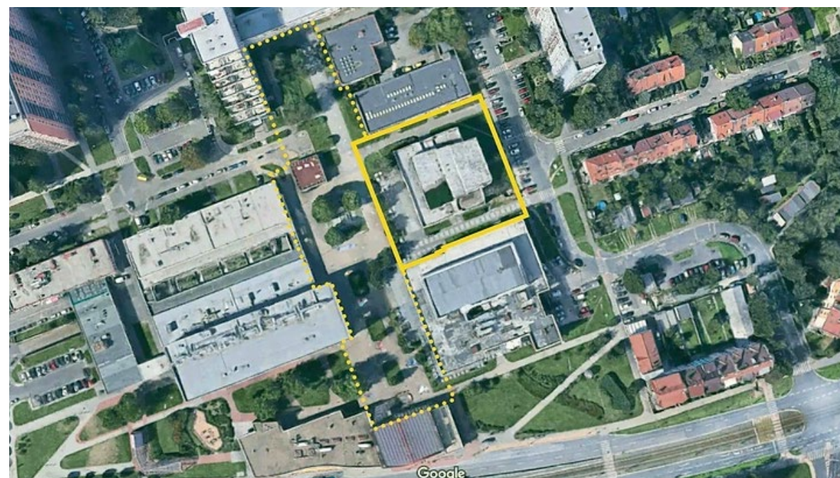
Blízke okolie metra Ládvi, centrum, Kultúrny dom Ládvi, pošta, obchodné domy
