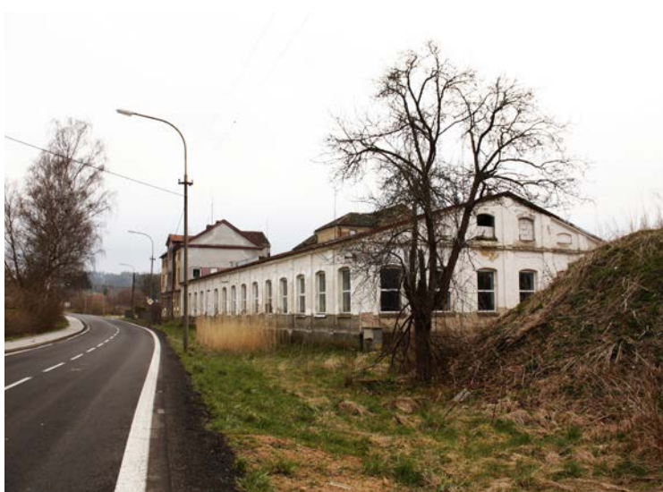
Nižší ze dvou zachovávaných továrních budov
