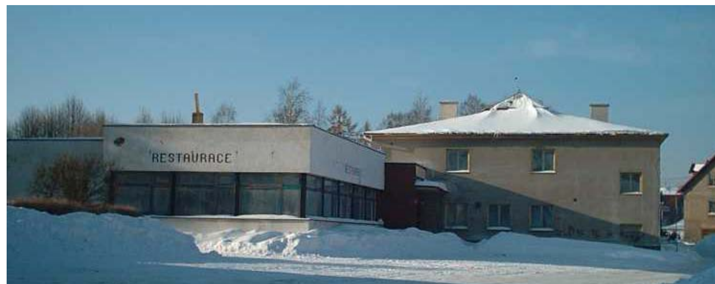
Stav objektu cca do roku 2004
