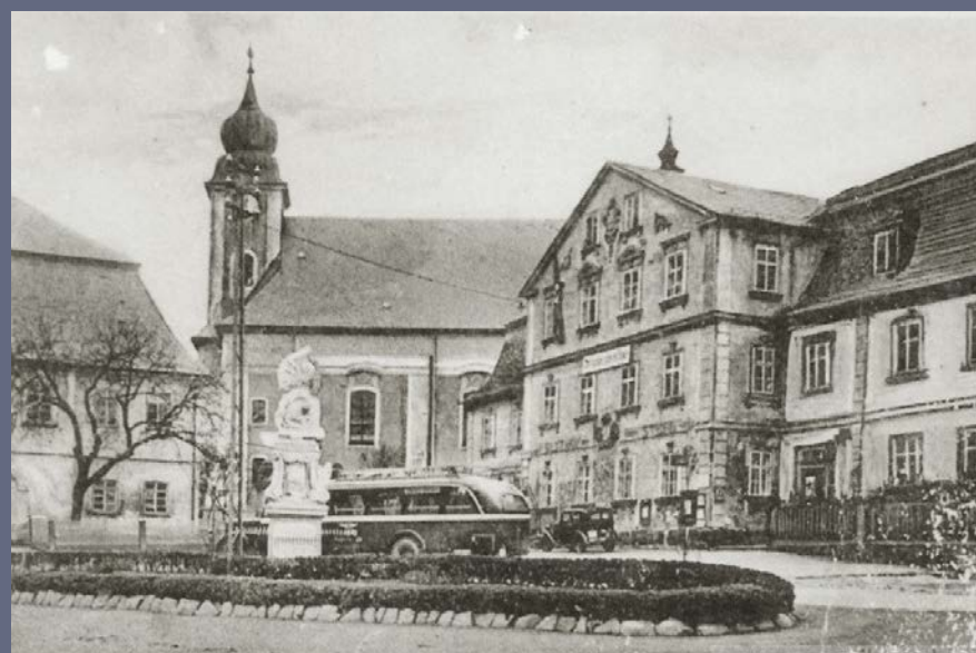
Archivní snímek náměstí s kostelem, farou (vlevo) a mohutnou budovou hostince (vpravo) v průhledu hlavní komunikací. Ve středu náměstí stojí dochovaná socha sv. Jana Nepomuckého.
