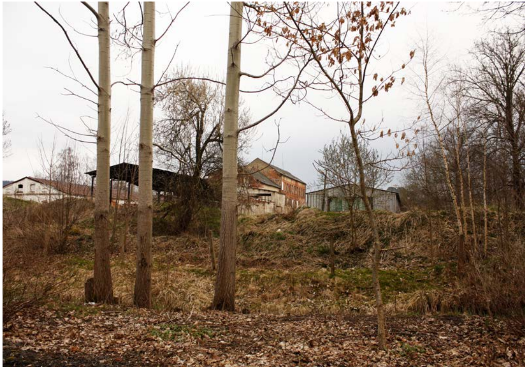
Pohled z městského parku přes potok na brownfield - současný stav
