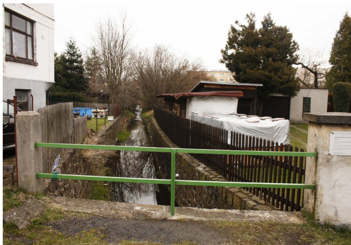
Místo č. 4 - současný stav regulovaného koryta potoka
