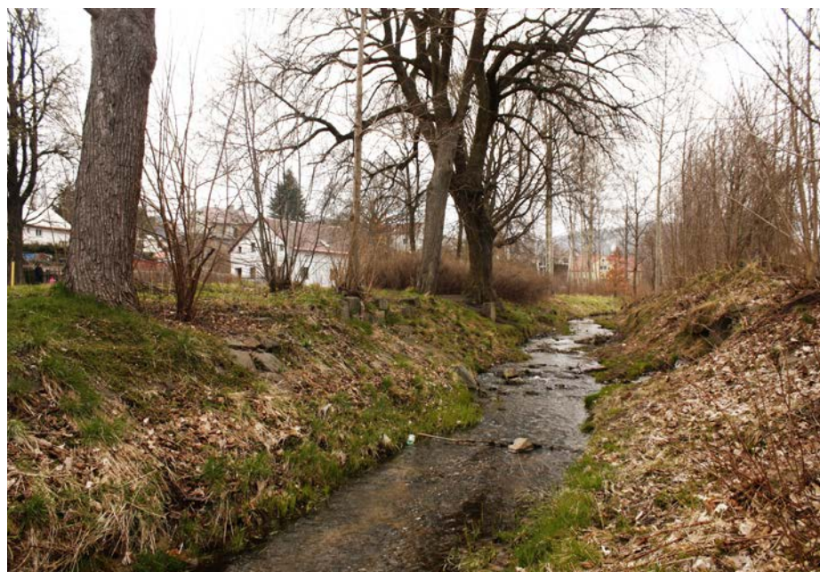
Místo č. 7 - současný stav úseku potoka mezi parkem a brownfieldem
