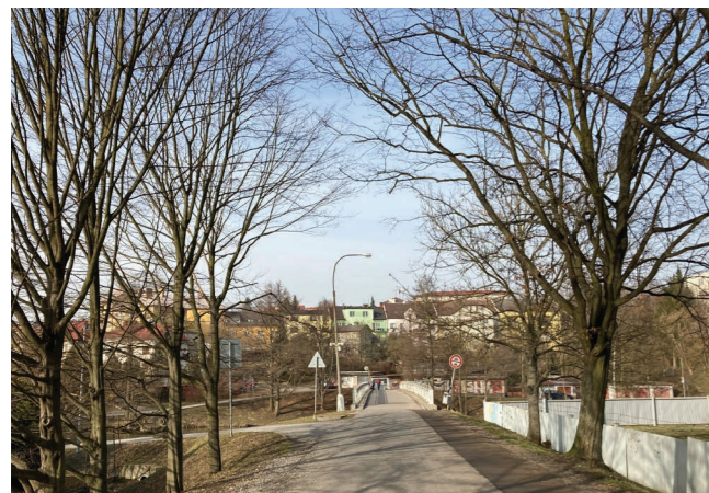
pěší lávka přes Sázavu
