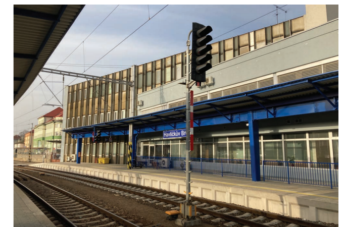
pohled z nástupiště na výpravní budovu
