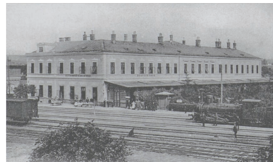
Původní budova nádraží
