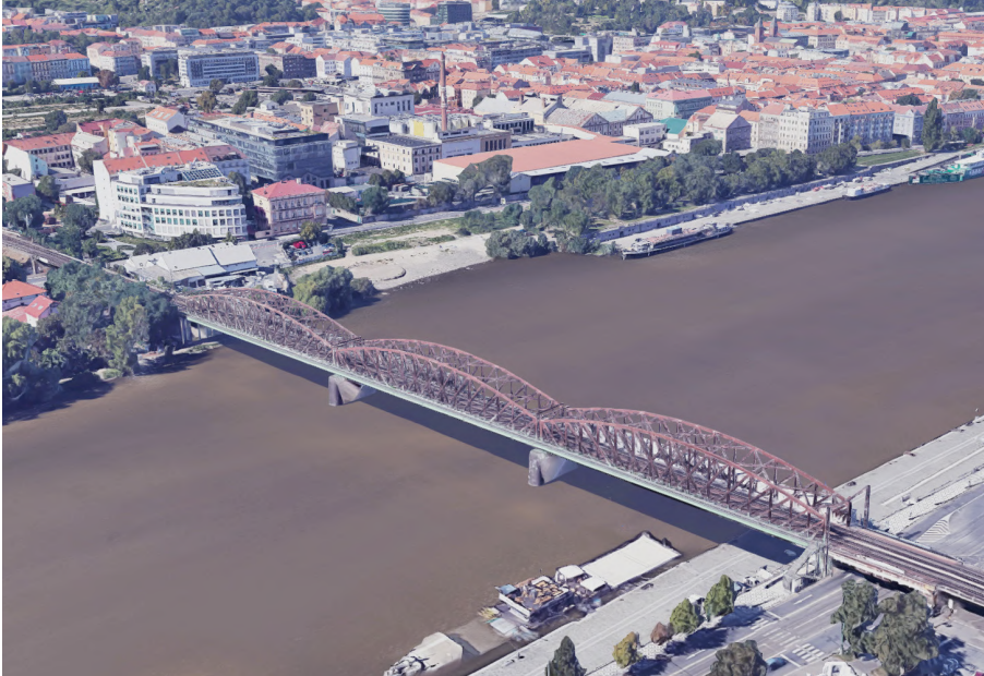
xxxi Železniční most u Výtoně Prostředí a podpůrná infrastruktura obrazu
