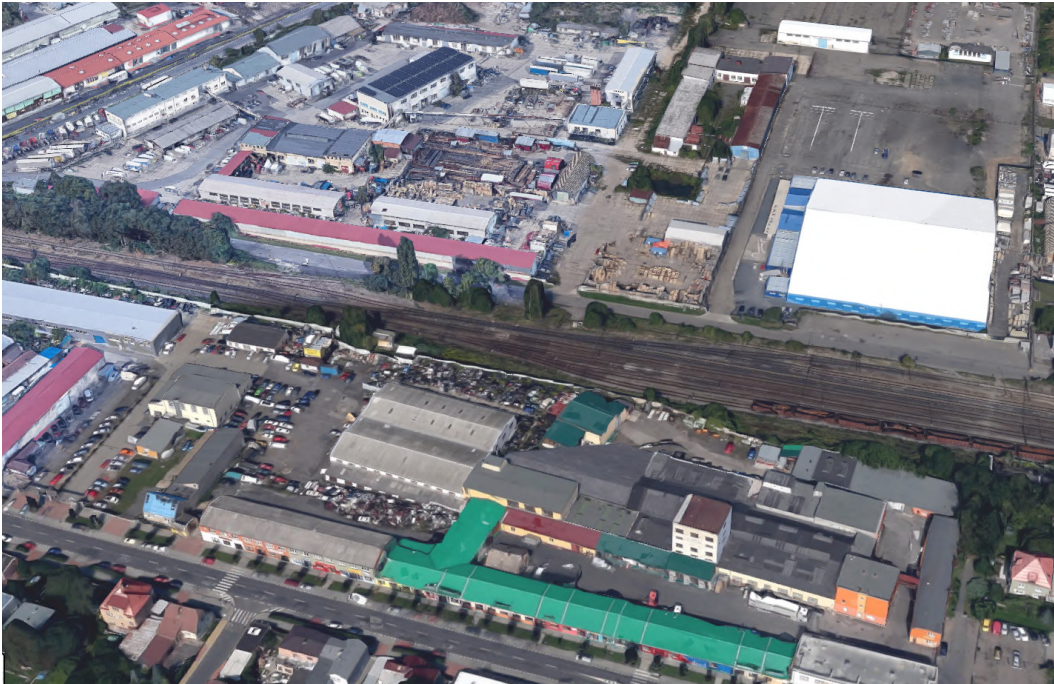
xxxix Průmyslový areál v Horních Počernicích Podél kolejí se běžně nachází továrny, velkoobchody či sklady
