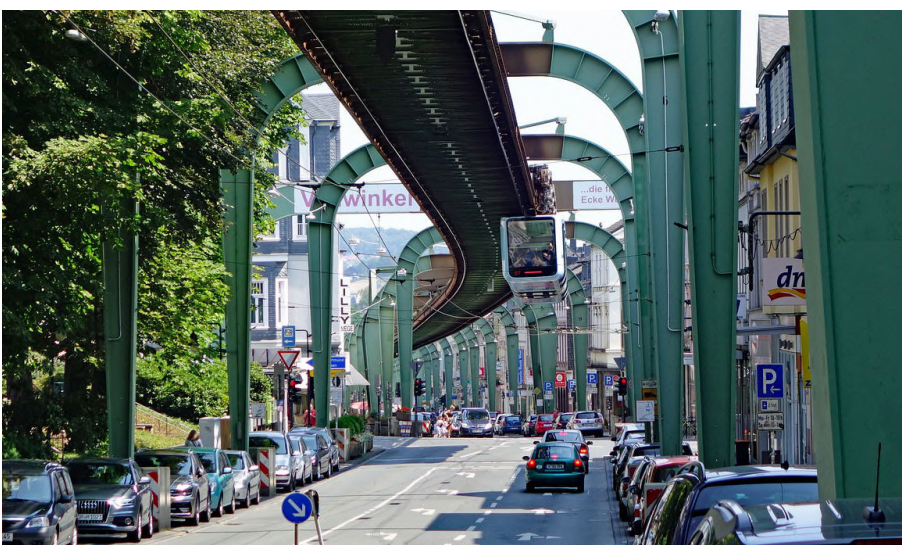
xxxix Část dráhy je vedena nad ulicemi města
