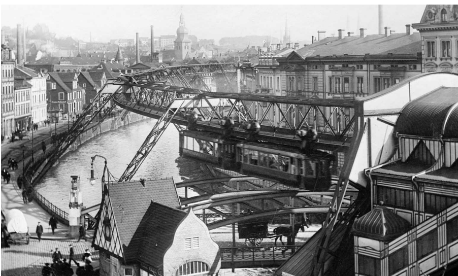
xxxviii Visutá dráha byla zprovozněna na začátku 20. století
