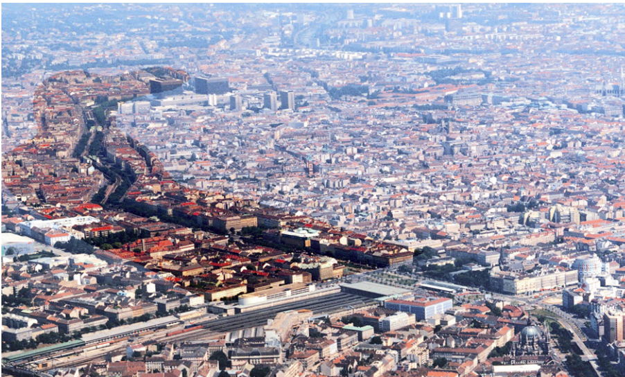
lii Revitalizace železničního mostu ve vídeňské čtvrti měla dopad na široké okolí
