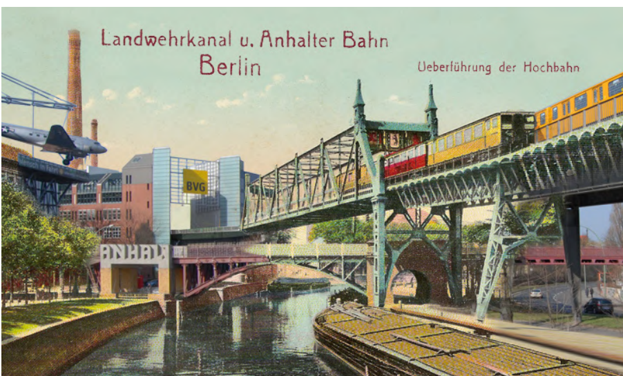
lvii Po průjezdu blokem vlak vyjíždí bránou nad řeku
