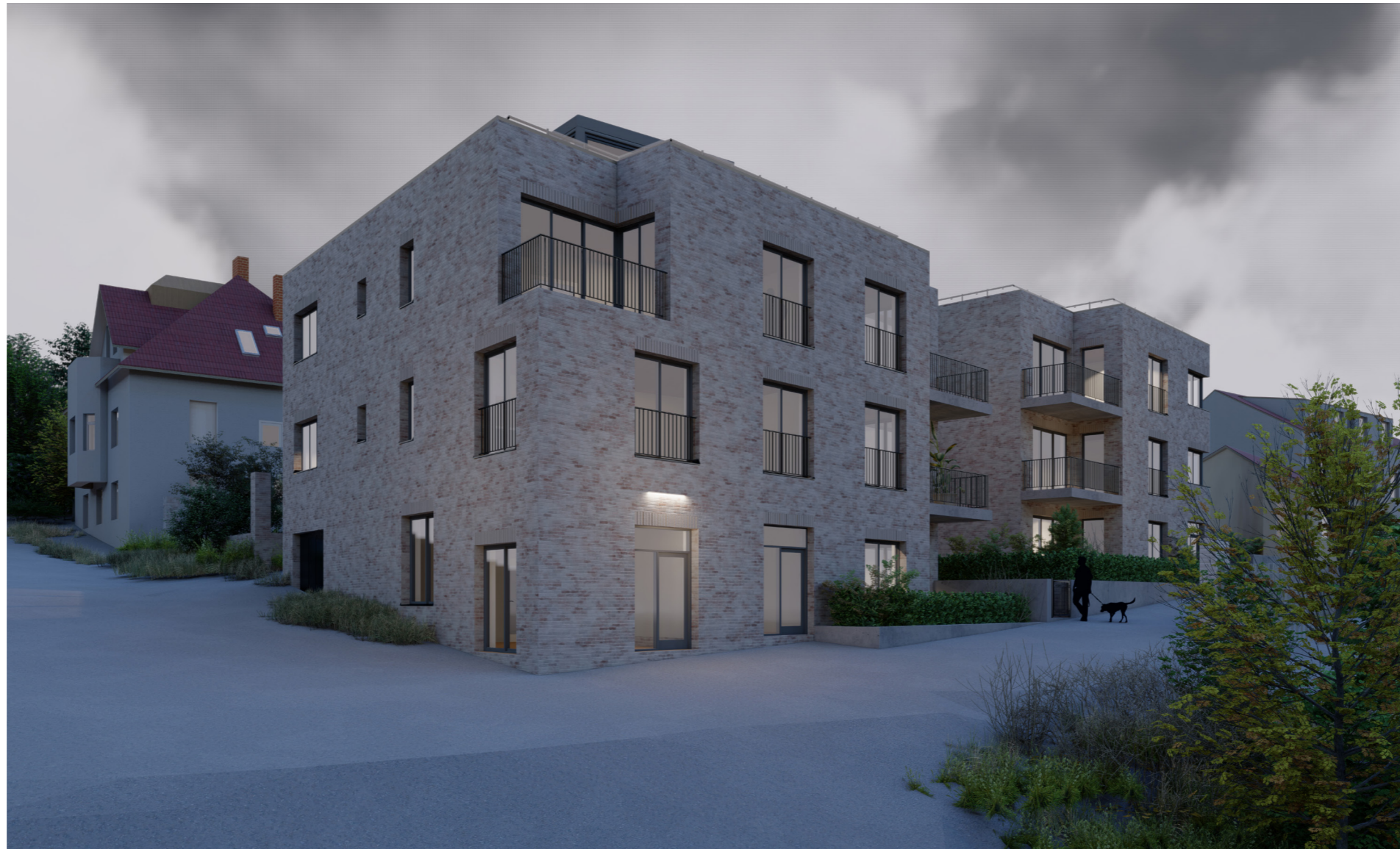
POHLED Z MOSTU
