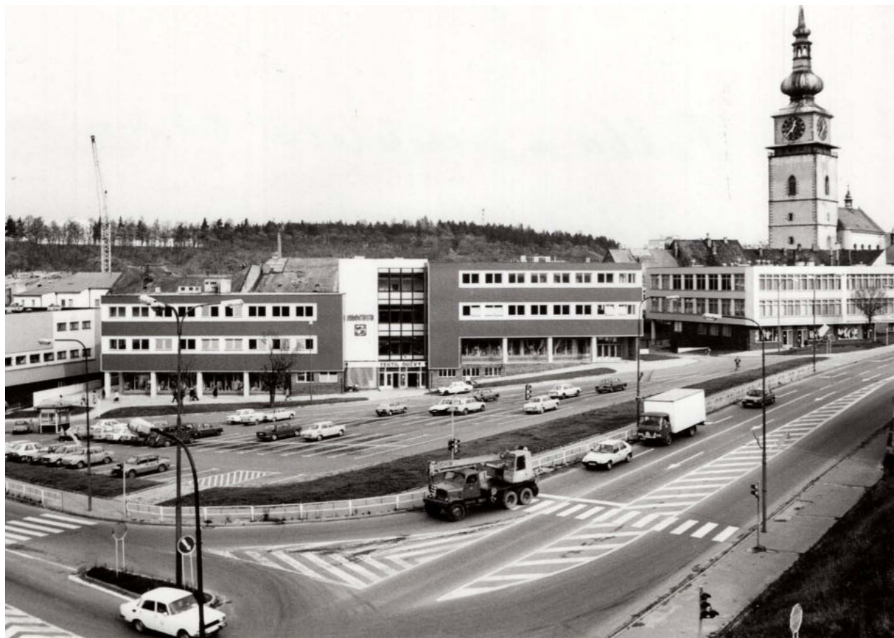
80. léta 20. století, dokončení průtahu městem
