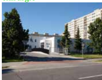
12. Úřad MČ Praha 11, budova Ocelíkova
