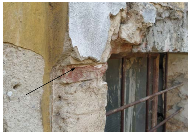
S8 Červený nátěr ve spodnější vrstvě okenní šambrány
