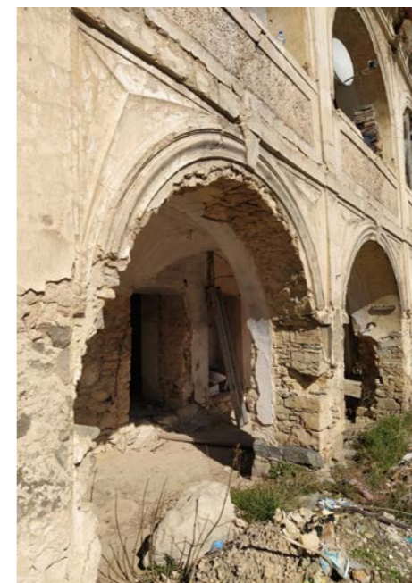
S4 Pilíř mezi 2. a 3. arkádou, z jedné strany vybíhá zubatá arkáda, z druhé hladká
