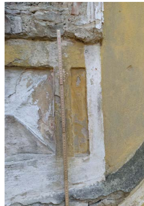
S11 Červený nátěr zdůrazňující plasticitu diamantování okna
