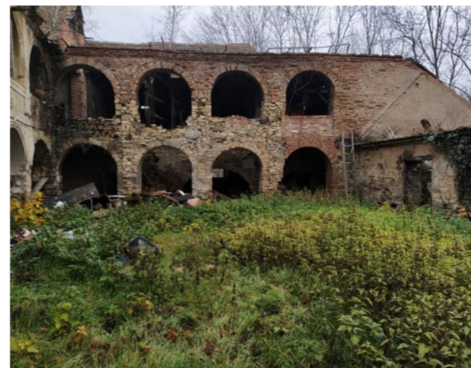
východní nádvoří průčelí
