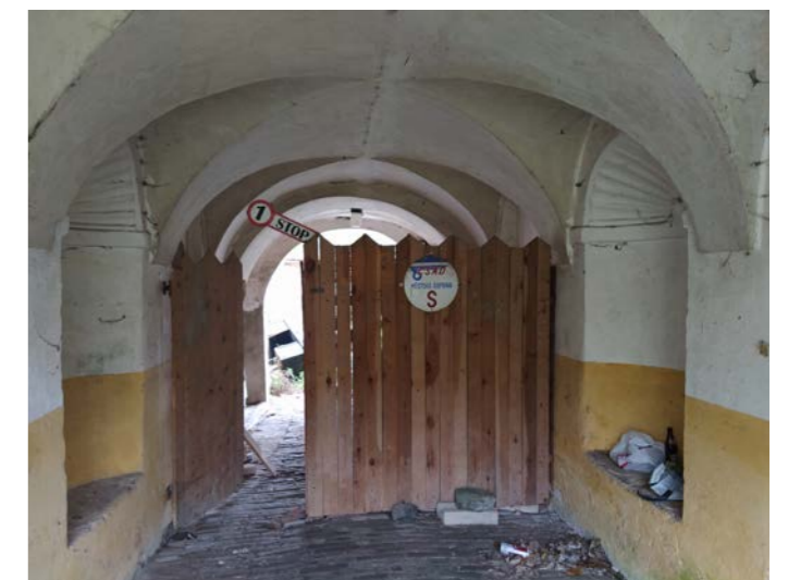
hlavní vstup do nádvoří - vjezd v severním křídle
