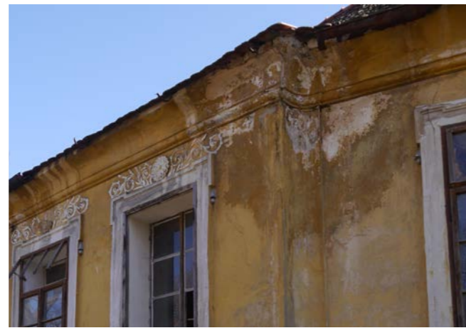
S16 Červený nátěr na korunní římsce
