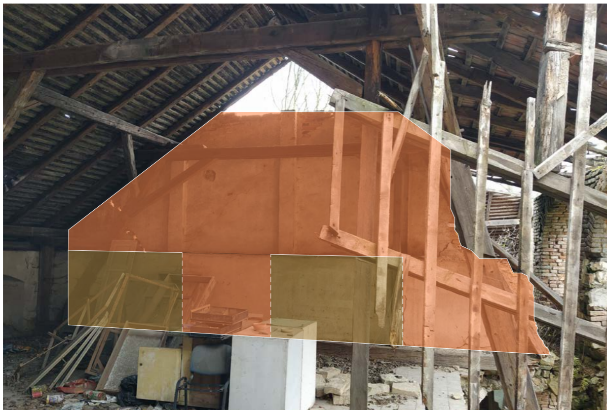
prostor někdejšího převýšeného sálu jižní stěna interiéru
