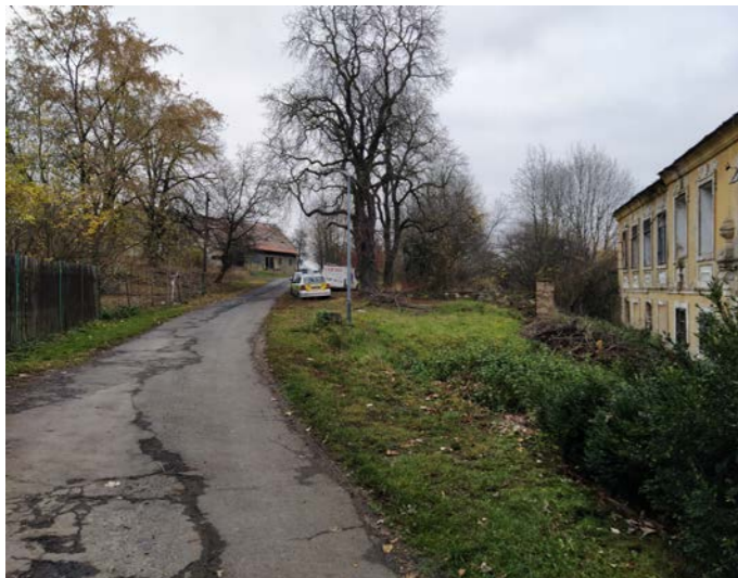
dvůr při pohledu z jihozápadu
