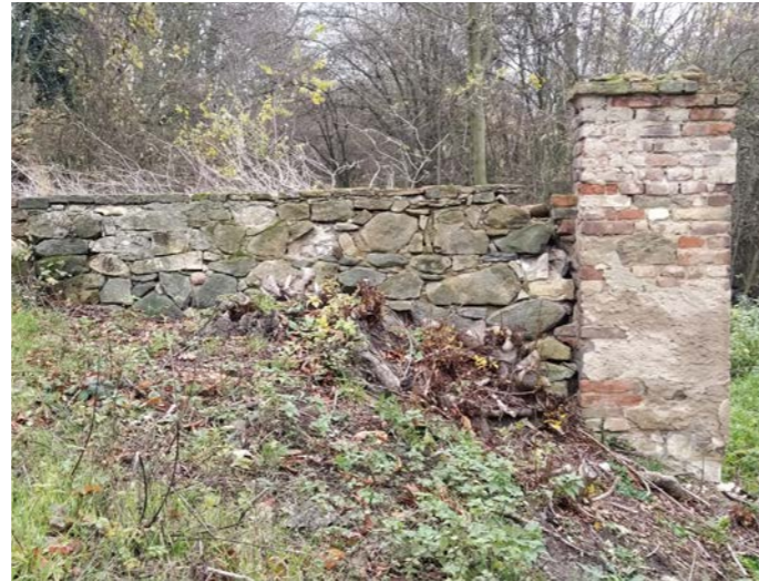
zahradní zeď se vstupní bránou severně od zámku
