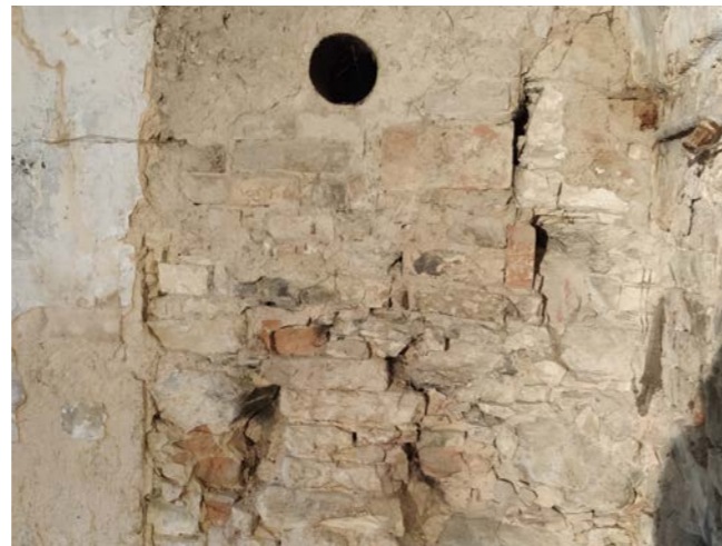
Zazdívka po dřívějším příkládacím výklenku
