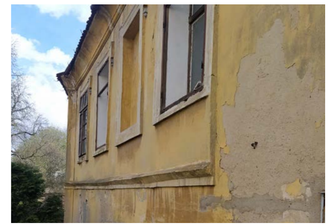
S17 Plastický výběžek nasvědčující zaniklému podokennímu štukovému rámu
