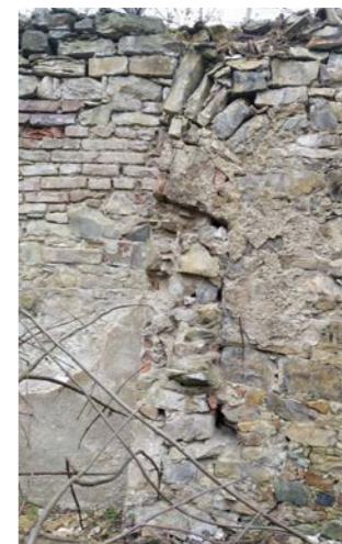
Pozůstatek záklenku otvoru, zachyceném ještě na plánu 1880
