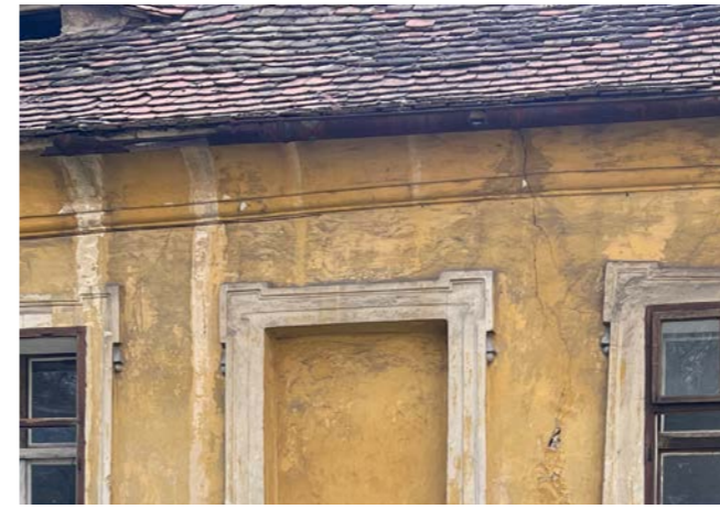
S17 Otisk bývalé suprafenestry s rozvilinami
