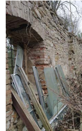
Pozůstatek záklenku otvoru, zachyceném ještě na plánu 1880
