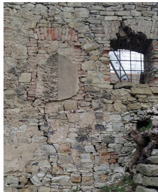
J4 Cihlová zadržka okenního otvoru
