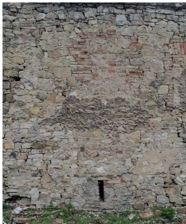
J3 Cihlová zadržka okenního otvoru
