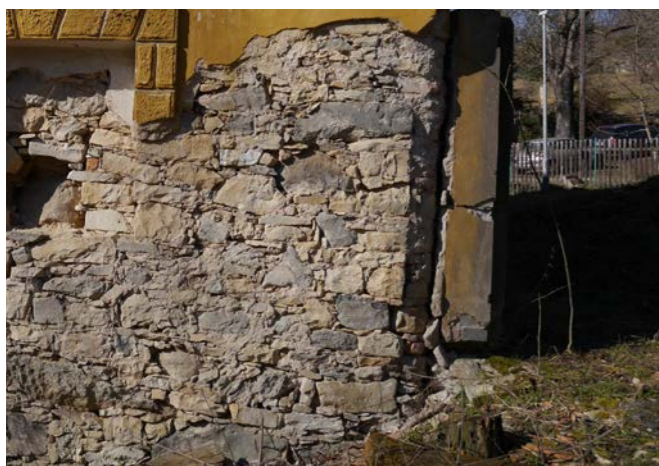
V16 Oblé barokní nároží organicky provázané s okolním zdivem datuje zdivo nároží do barokní etapy
