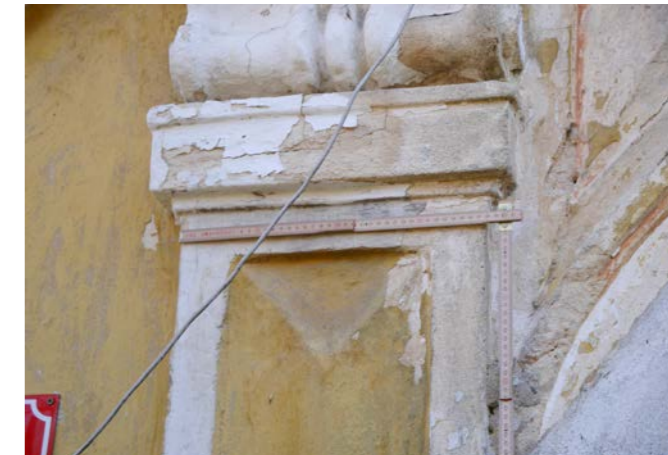
S12 Červený nátěr zdůrazňující plasticitu diamantování dřívku pilastru portálu
