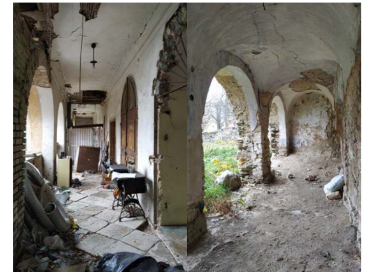
nádvorní chodba v patře a přízemí severního křídla
