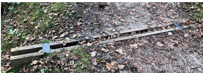
dřevěný žlab vedení vody
