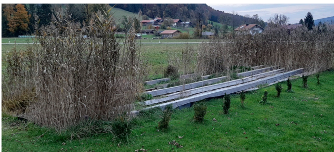
kořenová čistírna odpadních vod doporučená na soukromé pozemky
