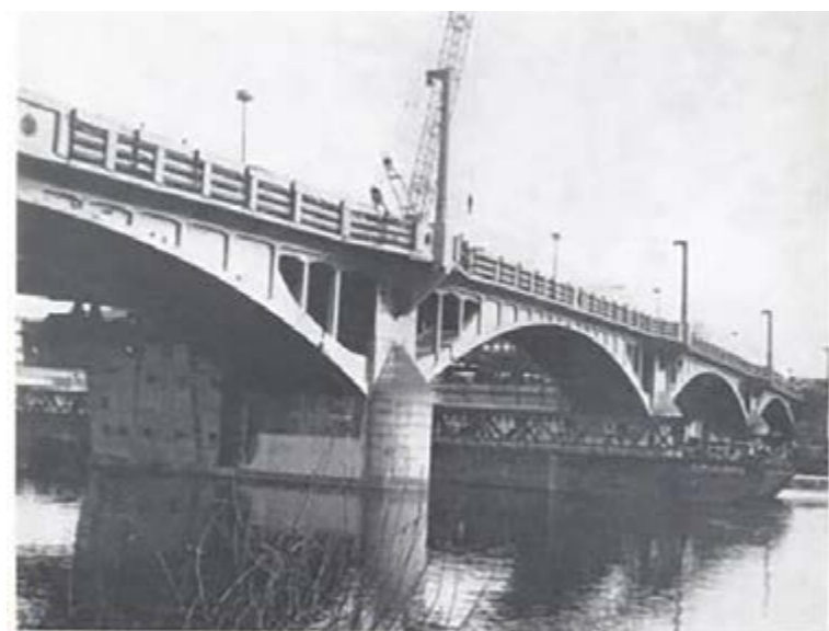
Obr.4.11. stavba mostu Barikádníků [10]
