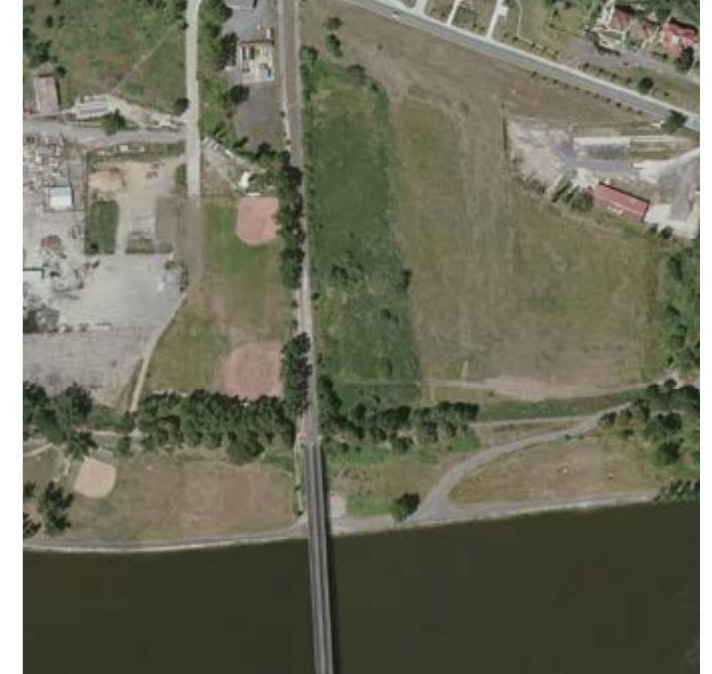
7920 Bubeneč. tunel, Trojský most 2021 2006
