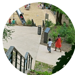
Litý beton na hlavní cestu
