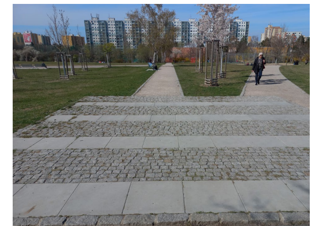
4 - V parku jsou použity kvalitní pochůzí materiály (probarvený asfalt, žulová dlažba, mlat atd.)
