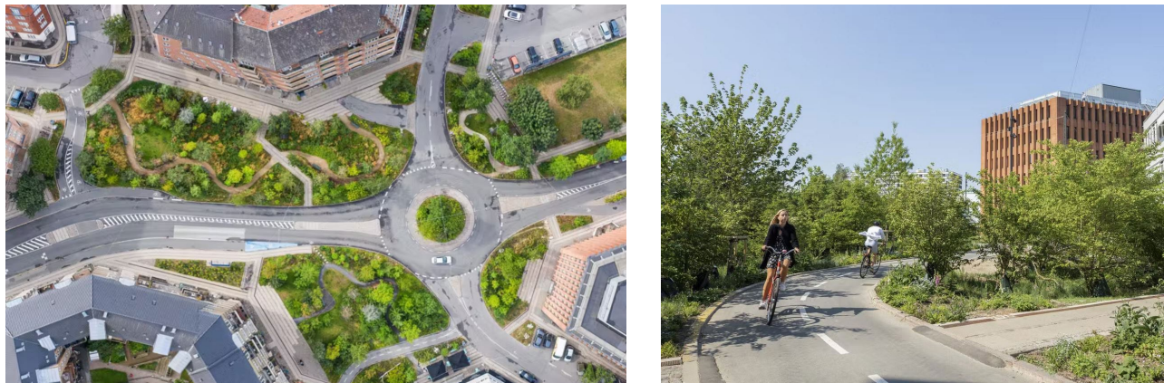
Náměstí Sankt-Kjeld's v Kodani, autoři: SLA - vytvoření ekologicky hodnotných biotopů na zbytkových plochách kolem silnice, využití domácích druhů rostlin
