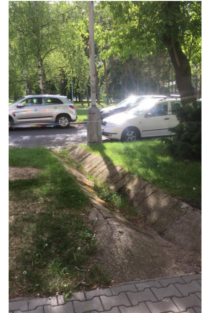
Děšťová voda je ze zpevněných ploch v současné době odvedena do vozovky, kde končí v kanalizaci.
