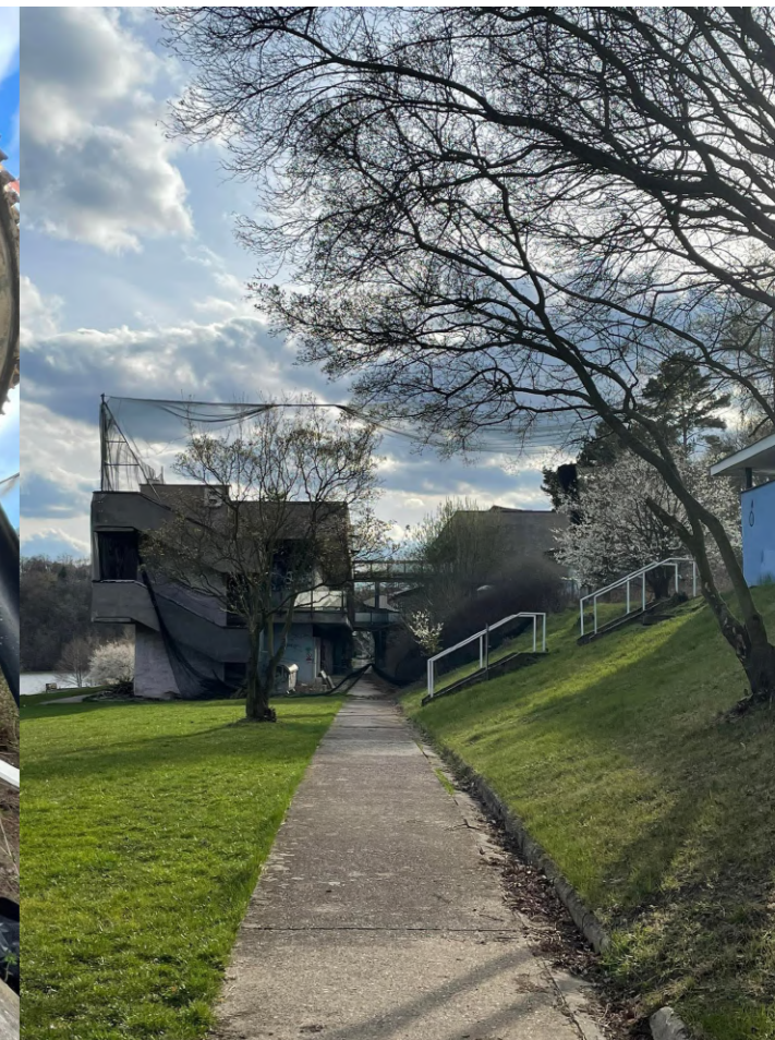
obr. 2 - Budovy jsou v katastrofickém stavu
