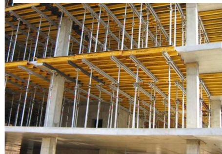
2 Stropní bednicí stůl Ringer
