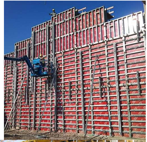
1 Stěnové bednění Ringer
