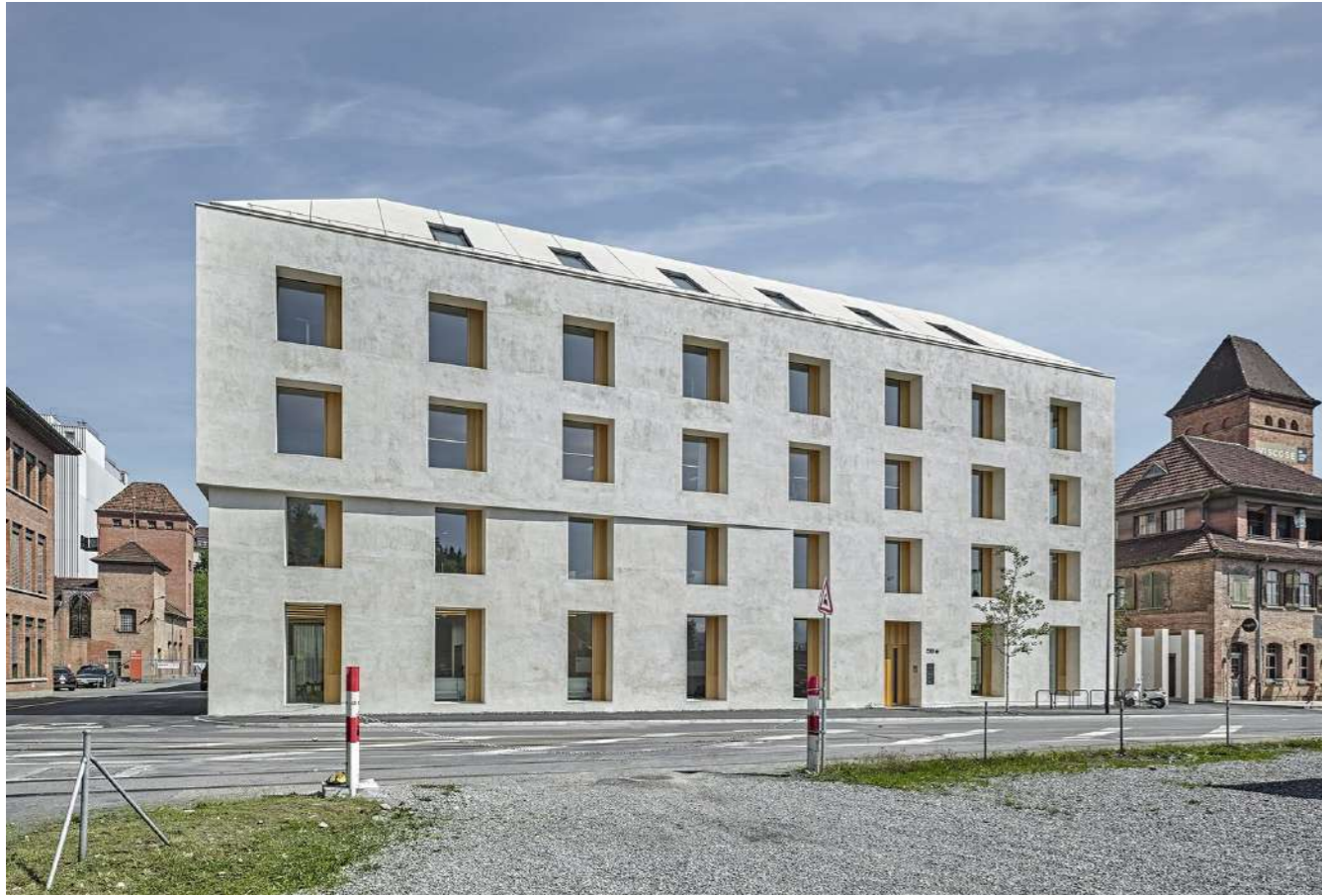
2226 Emmenweid, Emmenbrücke, Switzerland, baumschlager-eberle arkitekten Rekonstrukce, low-tech pasivní dům využívající minimum technologií [72]
