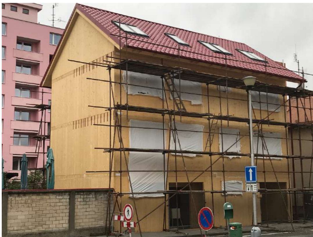
Nejvyšší dům z CLT panelů v ČR [71]
