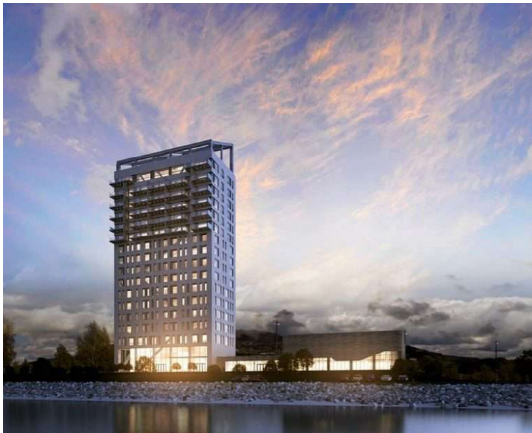
Nejvyšší dřevostavba v Norsku (18 pater, 81 m) Mjøs - Voll Arkitekter. Postavena z lokálních materiálů, rámová konstrukce (masivní dřevěné sloupy, trámy), ze dřeva jsou v ní i výtahové a schodišťové šachty. [66][67]
