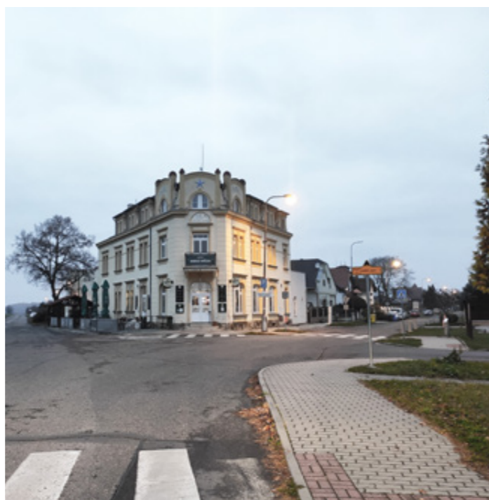
Hotel modrá hvězda, který sloužil pro ubytování lázeňských hostů na nároží ulic Lázeňská a Ke Hradištku. Svým umístěním a vzhledem si stále udržuje dominantnost a poznávací bod místa.
