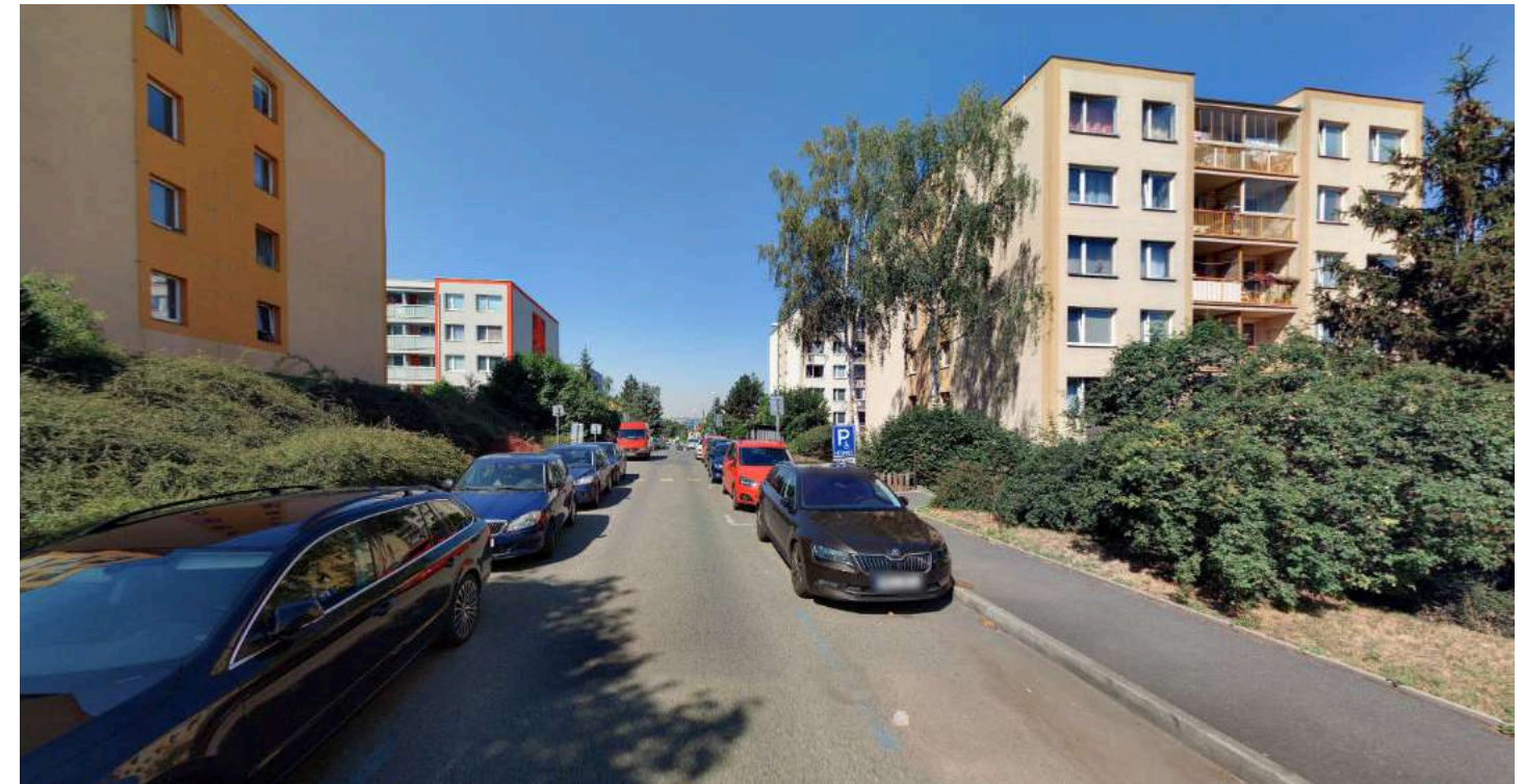
II. panelová výstavba z 80. let
