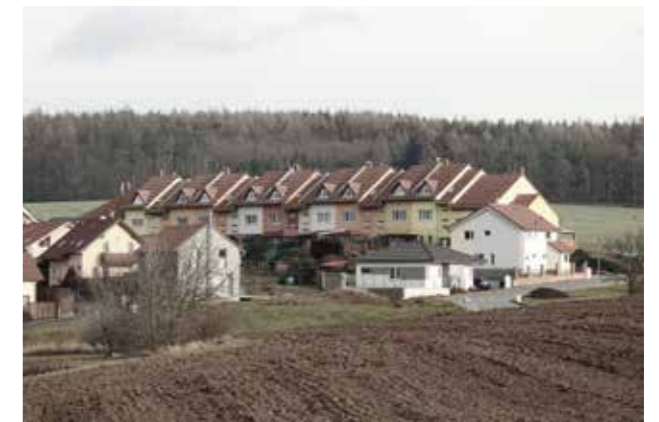
Řadové dvoupatrové domy - přestavba Kravína
