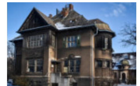
Obr.71.: Vila Na Zapadlém
