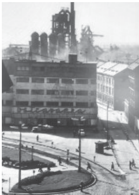
Obr.5.: Pohled na obchodní dům Ostravanka
