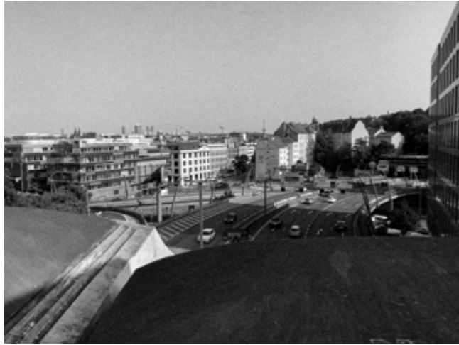
podhled od výjezdu ze Strahovského tunelu
