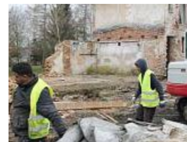
Bourání ubytovny na Větrovně 2015
