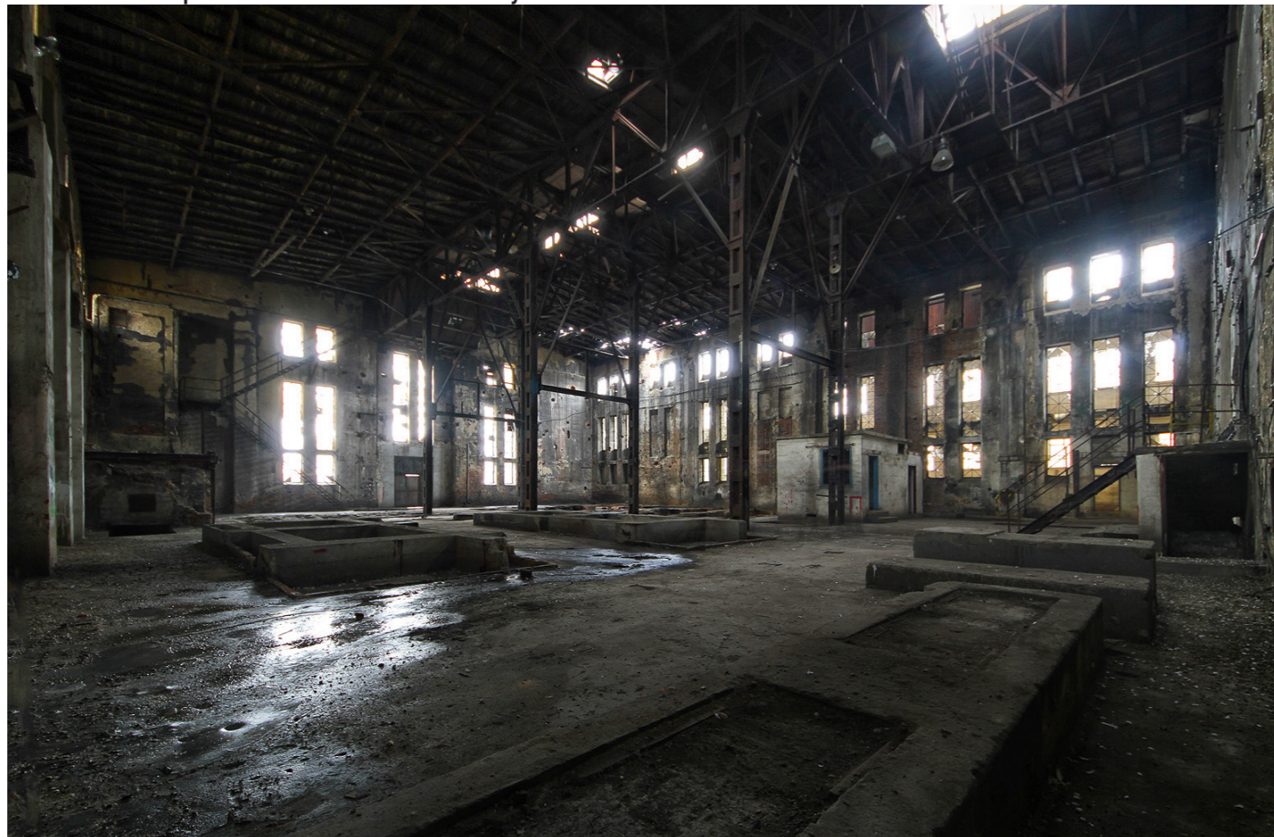
obr. 2.18 ↓ pohled do interiéru kotelny
