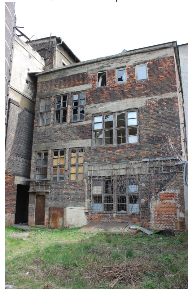
obr. A2.15 ↓ SZ fasáda s přístavbou
