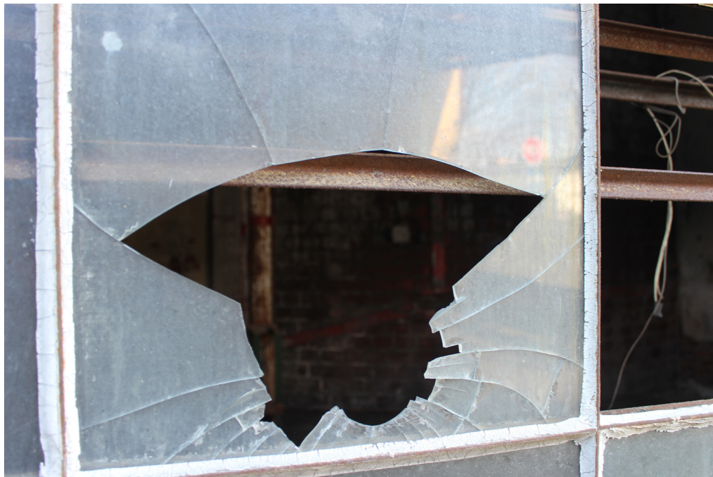
obr. A2.18 ↑ okenní výplně SV přístavby
