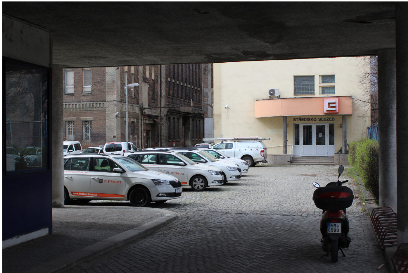
obr. A2.12 ↑ průchod k elektrárně z JV strany od řeky Běčvy
