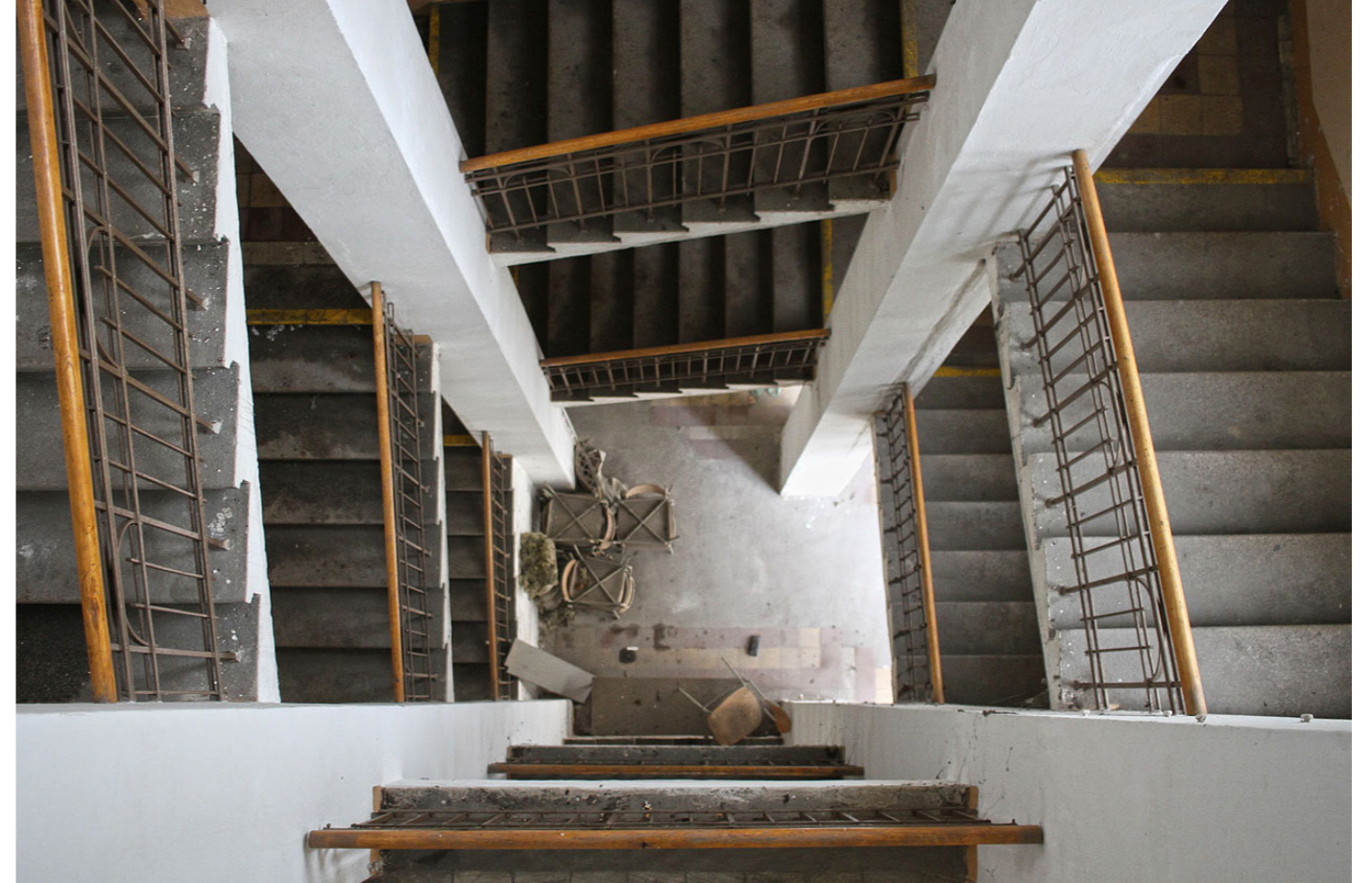
obr. 2.20 ↓ původní schodiště obsluhující administrativní zázemí objektu
