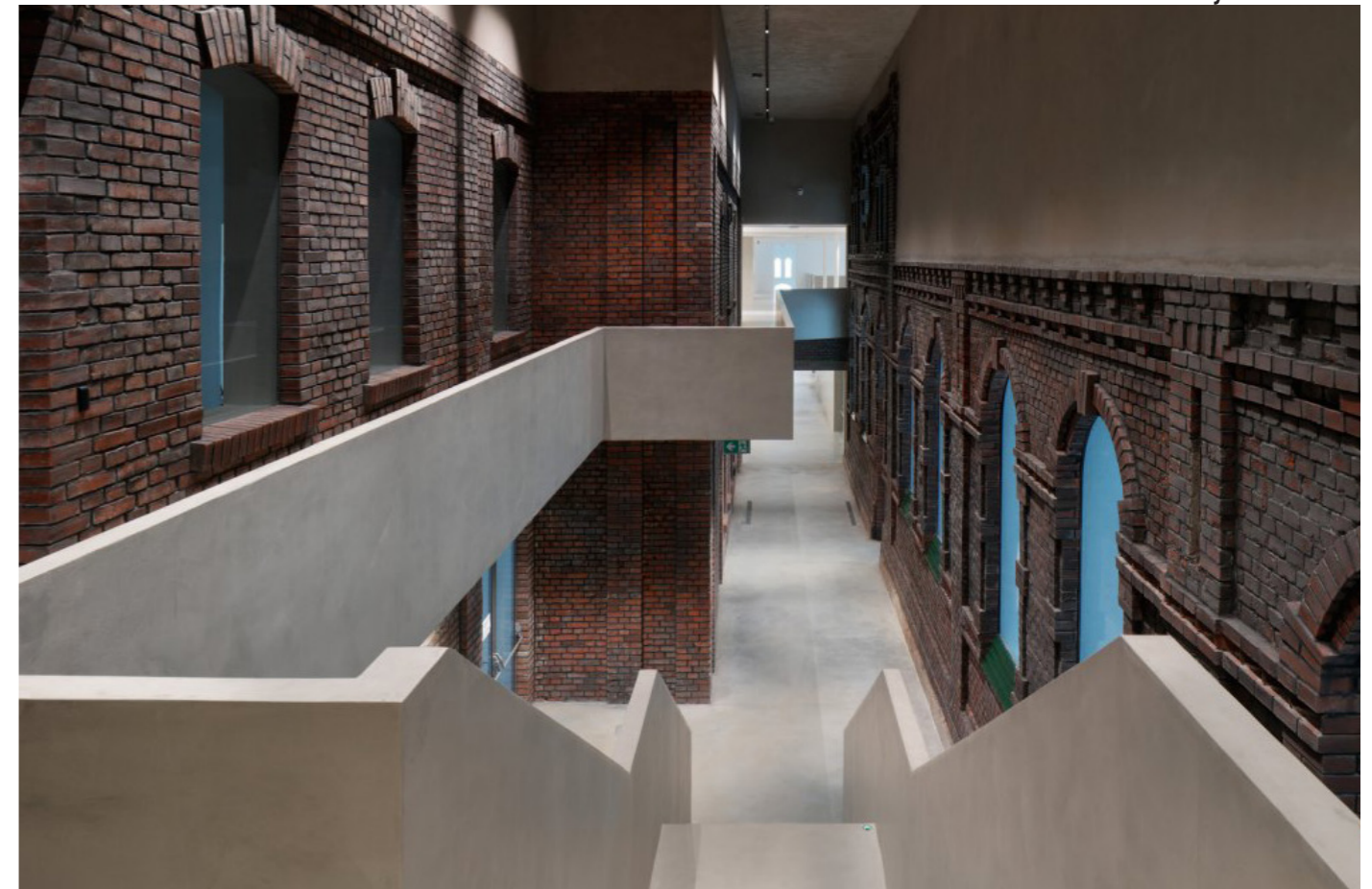
obr. 2.25 ↓ komunikační koridor se schodištěm vedoucím k administrativní části budovy
