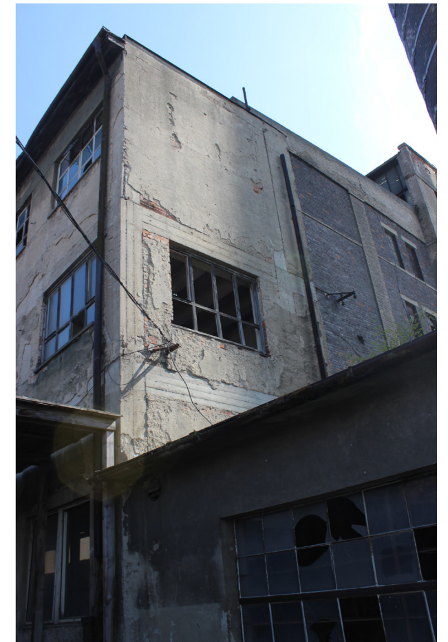
obr. A2.16 ↑ SV fasáda s přístavbou
