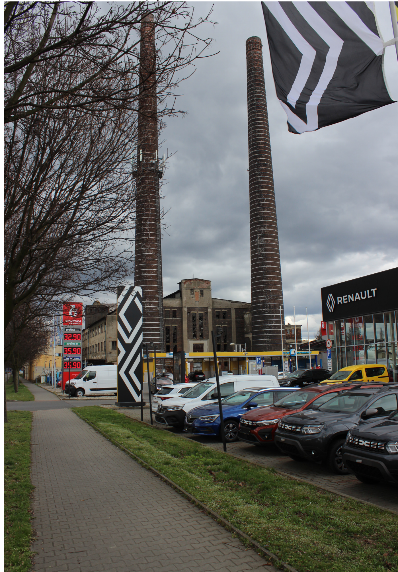
obr. A2.11↓ pohled na elektrárnu, příjezd ze SZ od Olomouce
