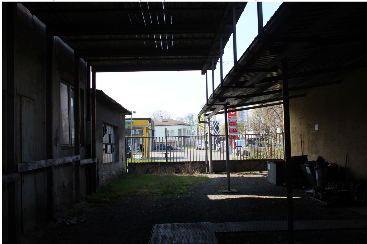
obr. A2.19 ↓ průhled směrem od řeky Bečvy k samoobslužné automyčce
