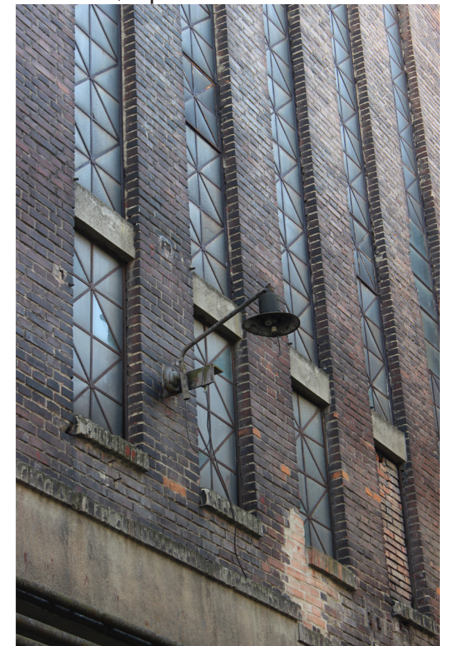
obr. A2.17 ↓ pásová okna na SV fasádě
