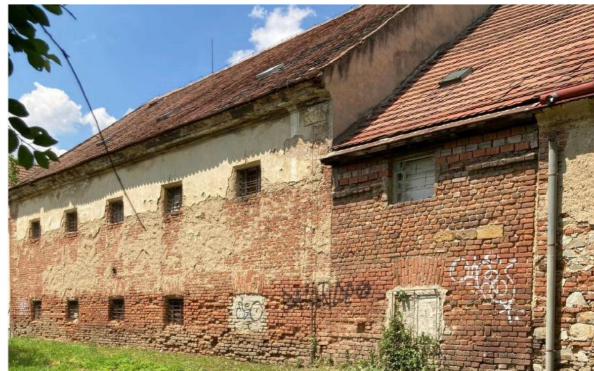
Obr. 19 Sýpka – severní pohled 62
