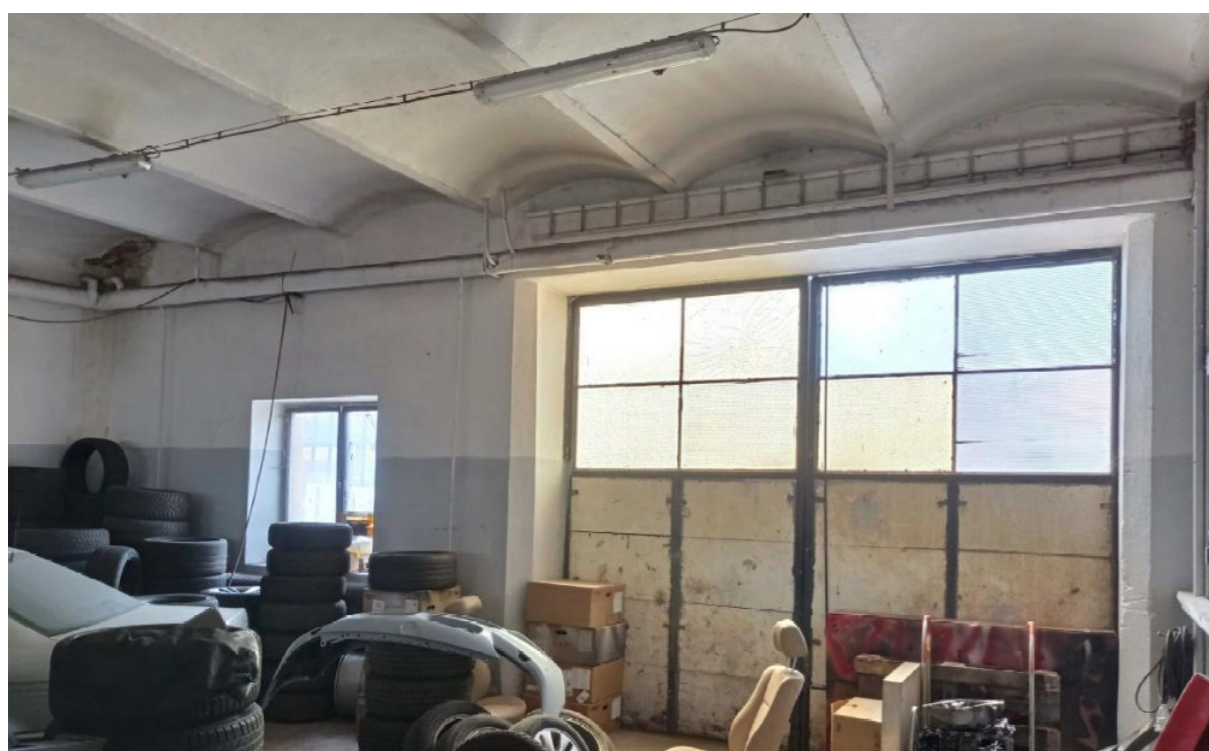
Obr. 15 Hospodářská budova – interiér 58
