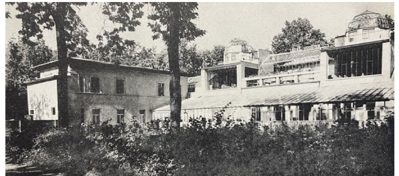
[14] Jižní pohled na budovu Slunečních lázní s přístavbou prosklené verandy (1931) a s pokojovým křídlem vlevo (1905)
