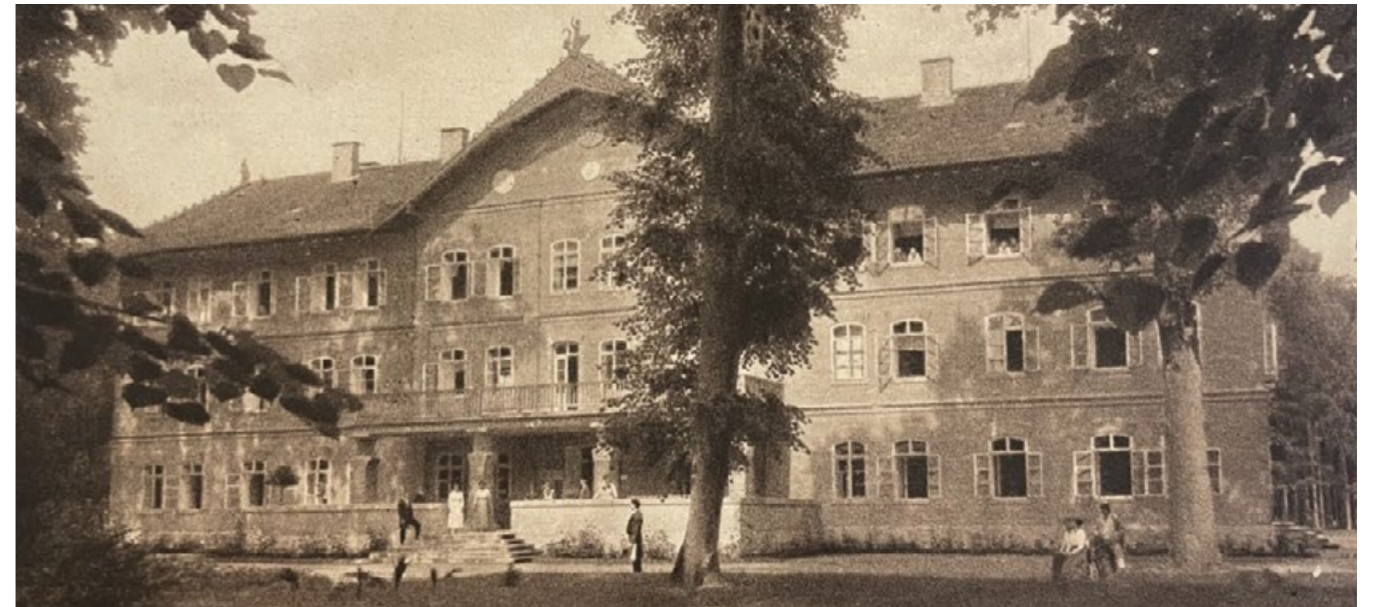
[14] Přístavba markýzy/balkonu nad vstupem a zídky kolem vyvýšené vstupní terasy (pravděpodobně po roce 1917)
