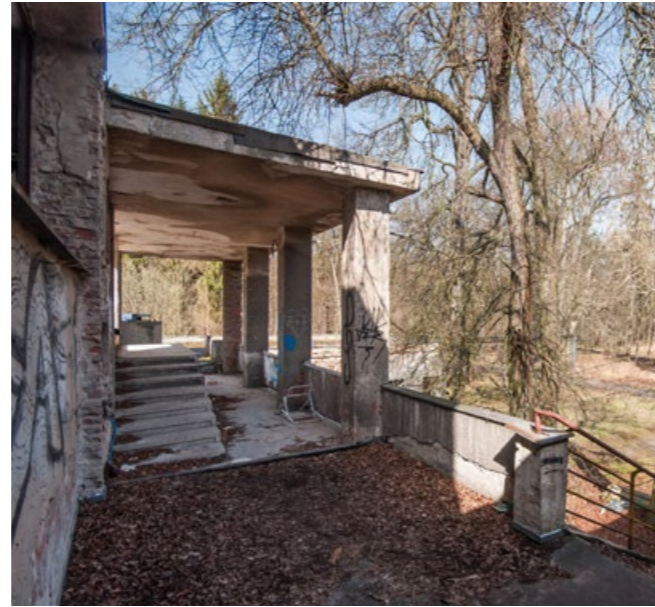
[9] Balkon na severovýchodní fasádě
