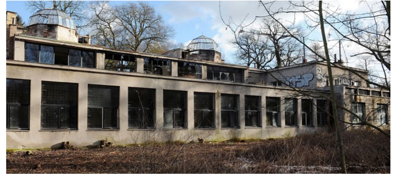
[10] Jihozápadní fasáda bývalého sálu
