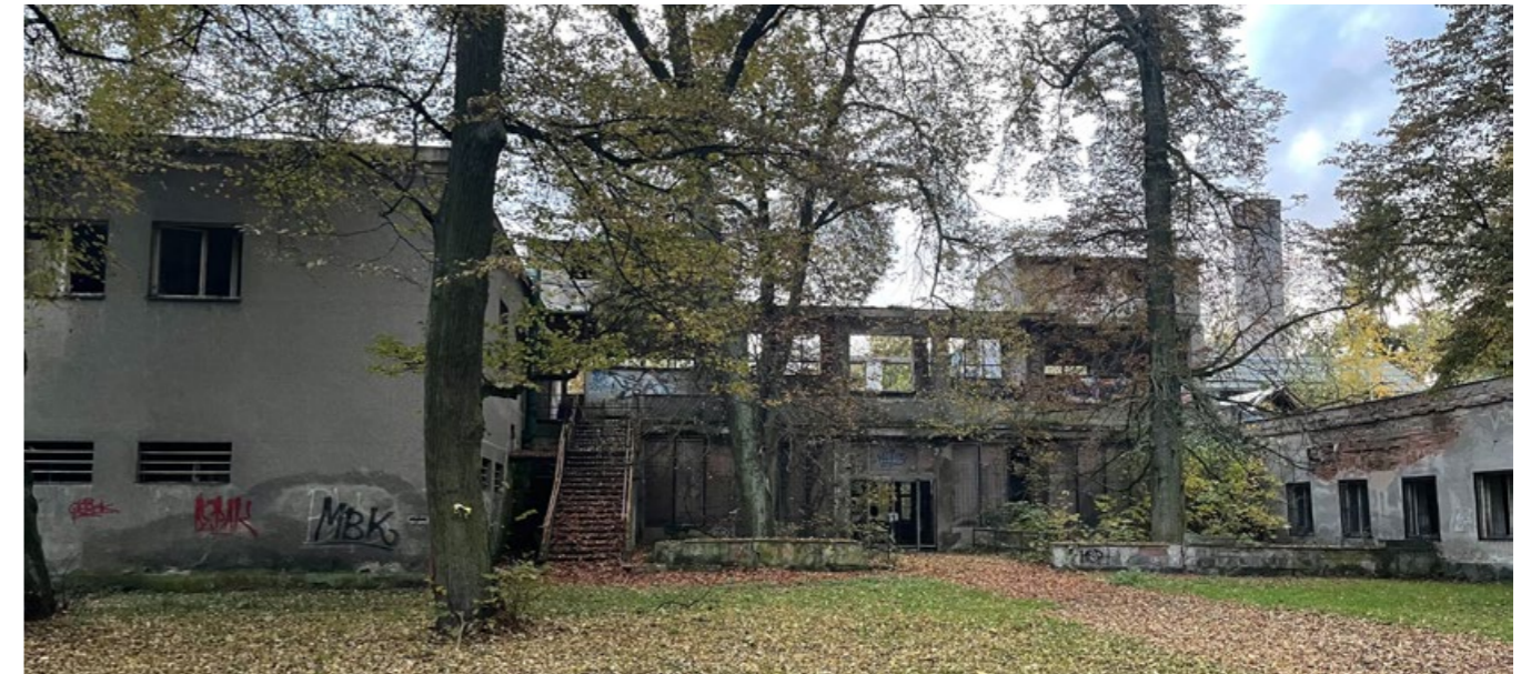
Severovýchodní fasáda s hlavním vstupem
