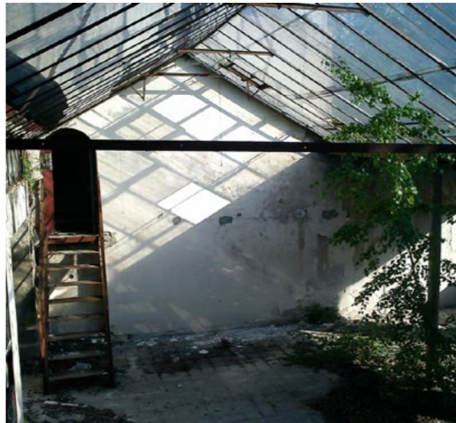
[13] Skleník na střešní terase (solárium)
