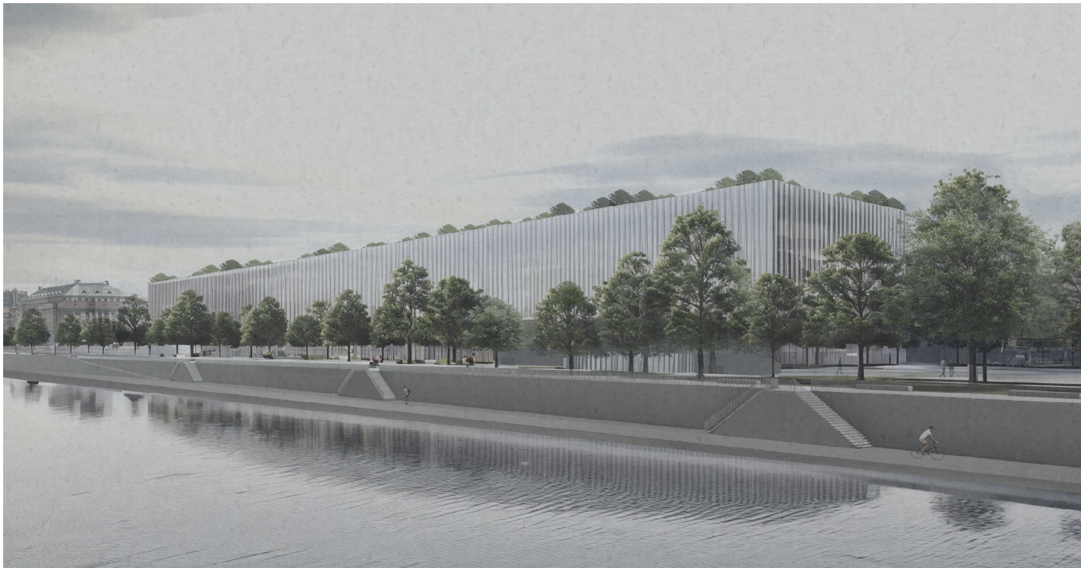
Pohled z Štefánská mostu
