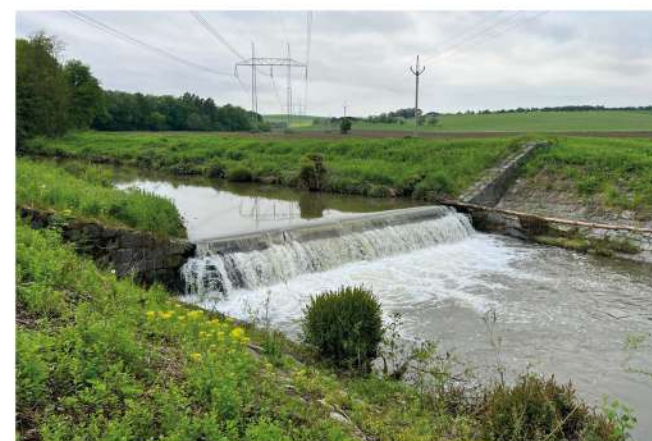
Obr.161: současný kamenný stupeň na řece Juhyně omezuje migraci živočichů vyskytujících se v řece, někteří živočichové nejsou schopni přeskočit stupně vysoké 1m
