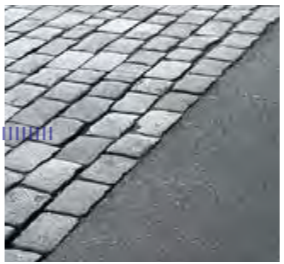
súbeh vozovky z asfaltu a vozovky z kamennej dlažby
