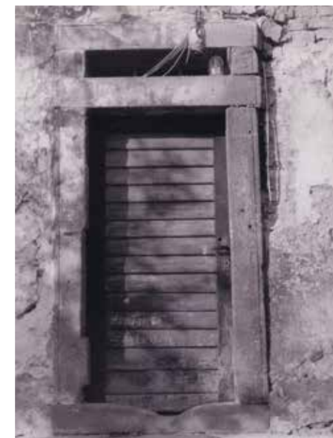
Vstup do objektu z jižní strany
