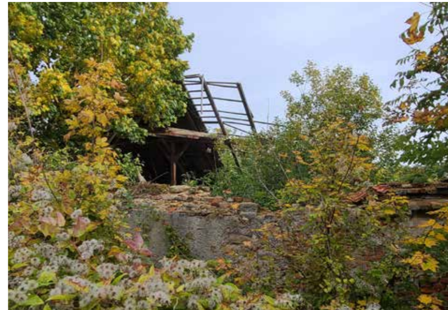
Pohled na středovou část ovčírny
