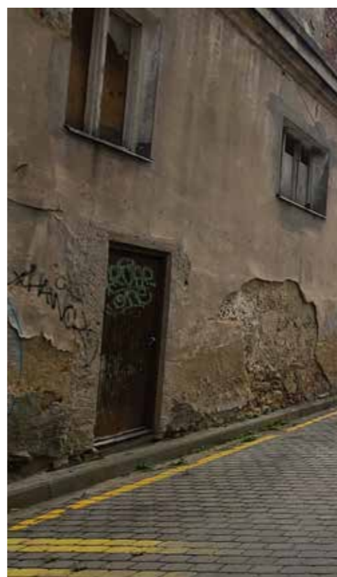
Západní vstup do objektu
