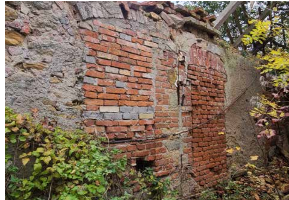
Jižní zazděný vstup do objektu dvorní fasády
