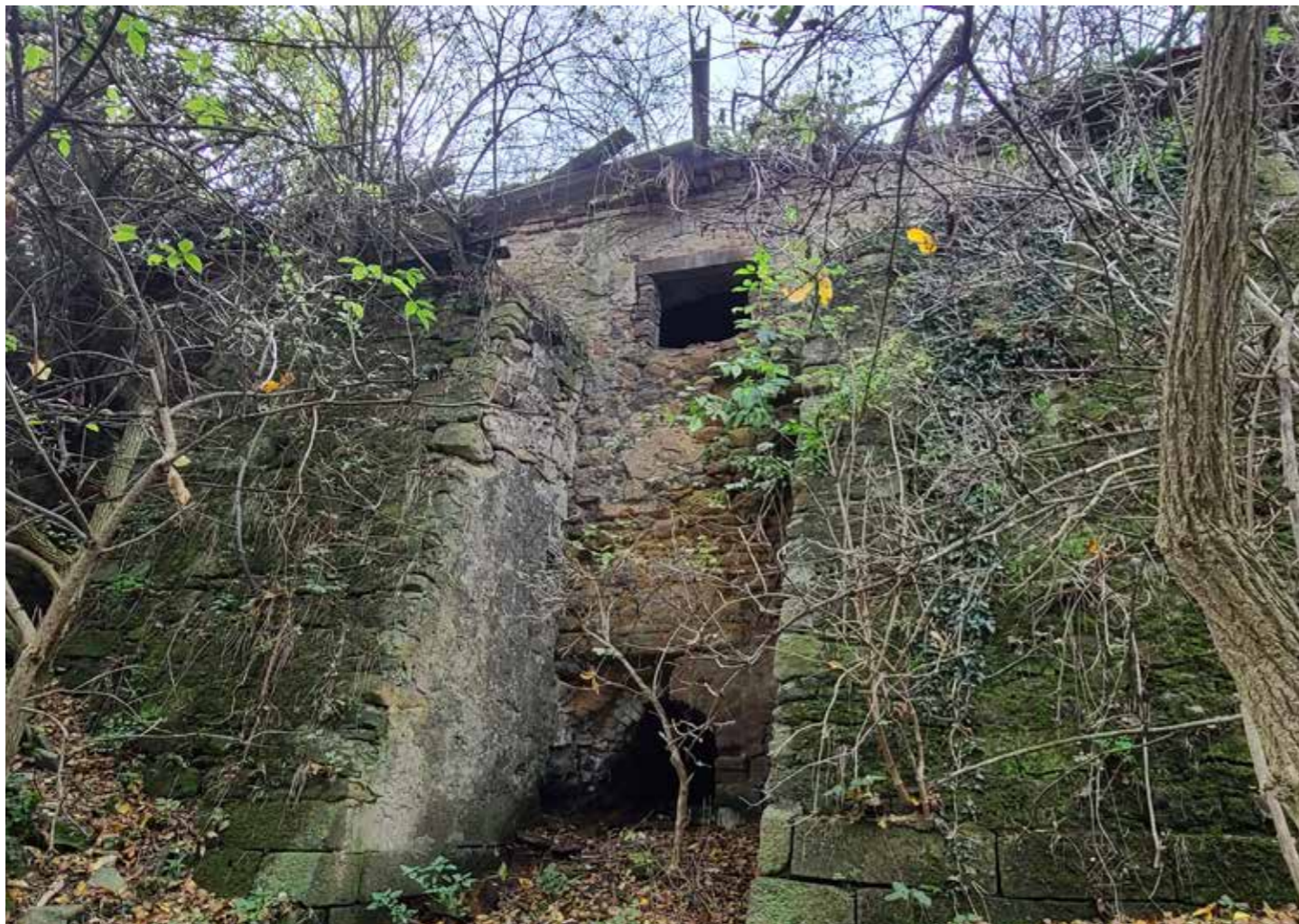
Opěrné pilíře na východní straně objektu
