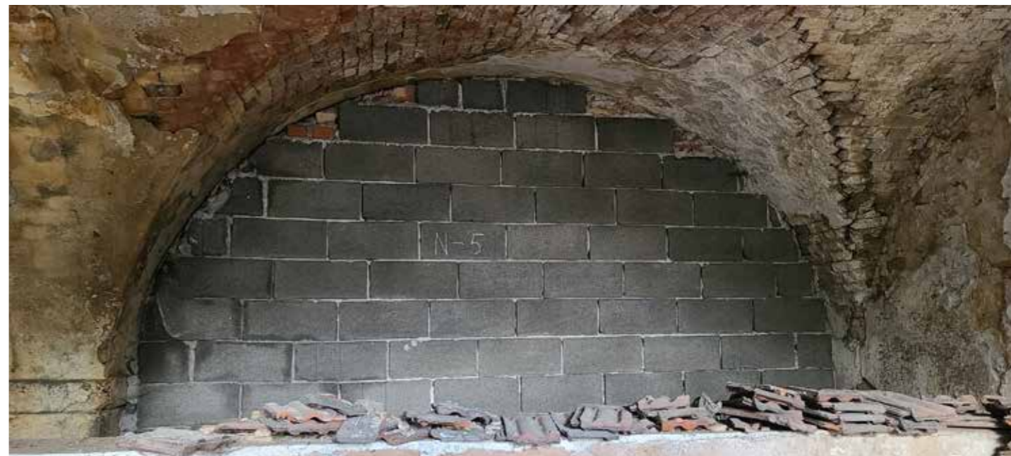
Pohled na novodobou příčku z tvárnic
