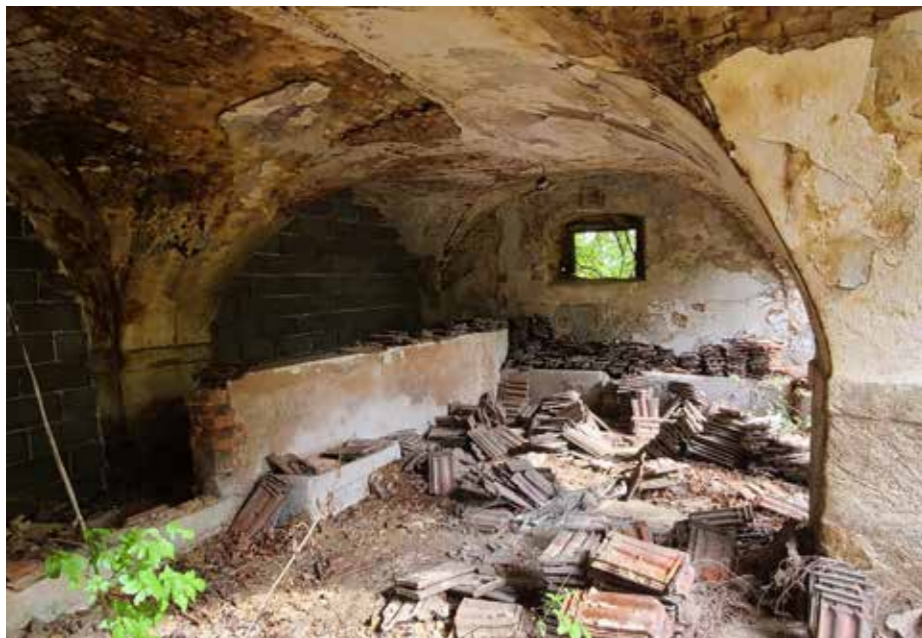
Novodobá příčka mezi severní a jižní částí
