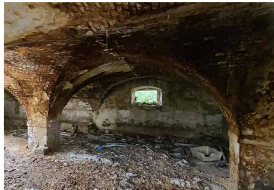
Pohled na křížové klenby v severní části objektu
