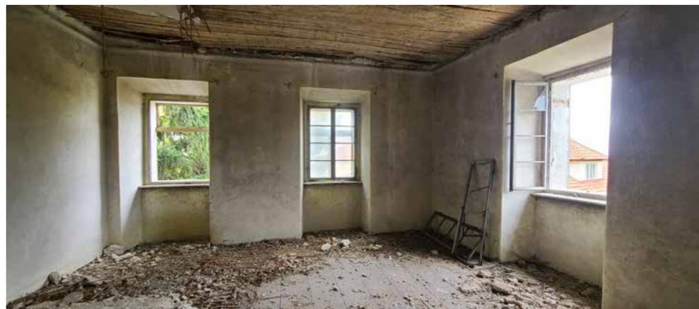
Sverozápadní pokoj v prvním patře
