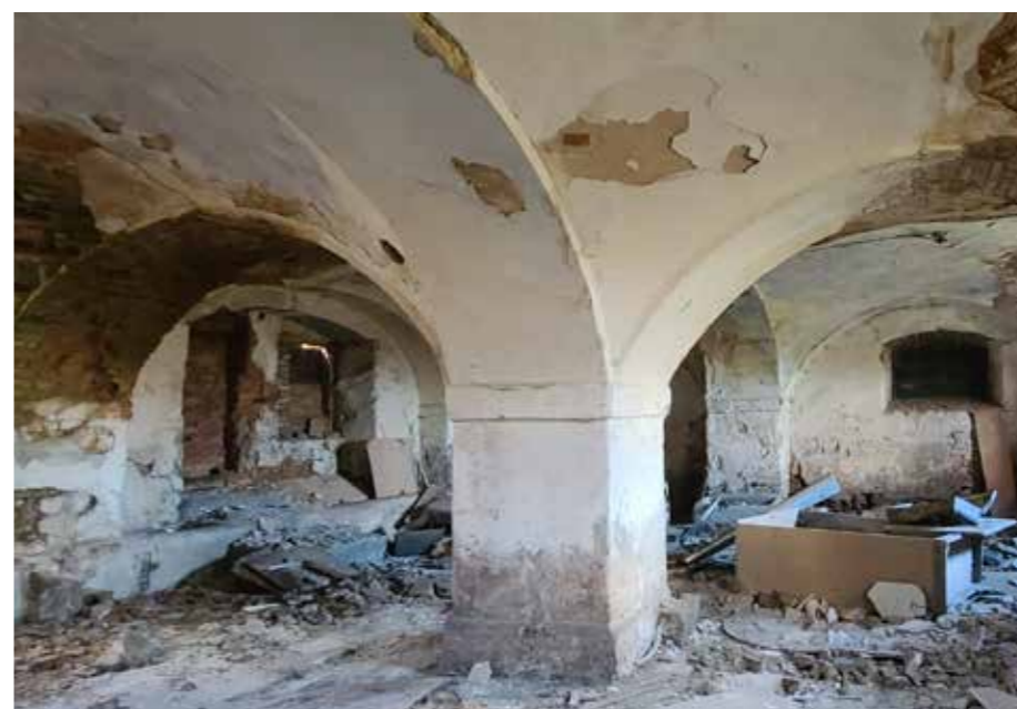
Pohled na českou placku v severní části objektu
