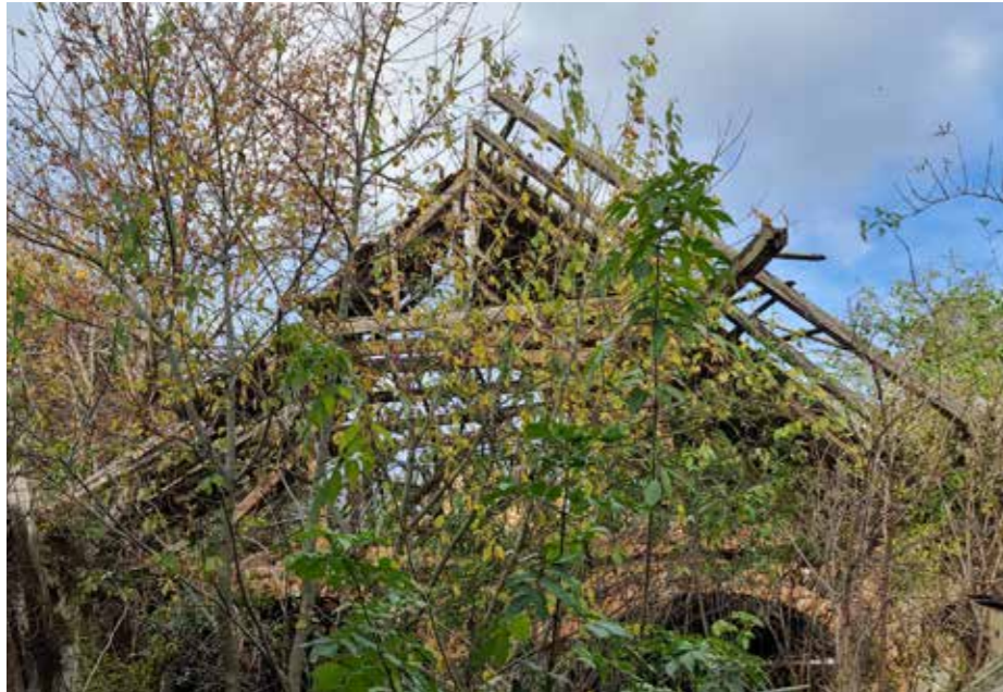
Pohled na torzo krovu
