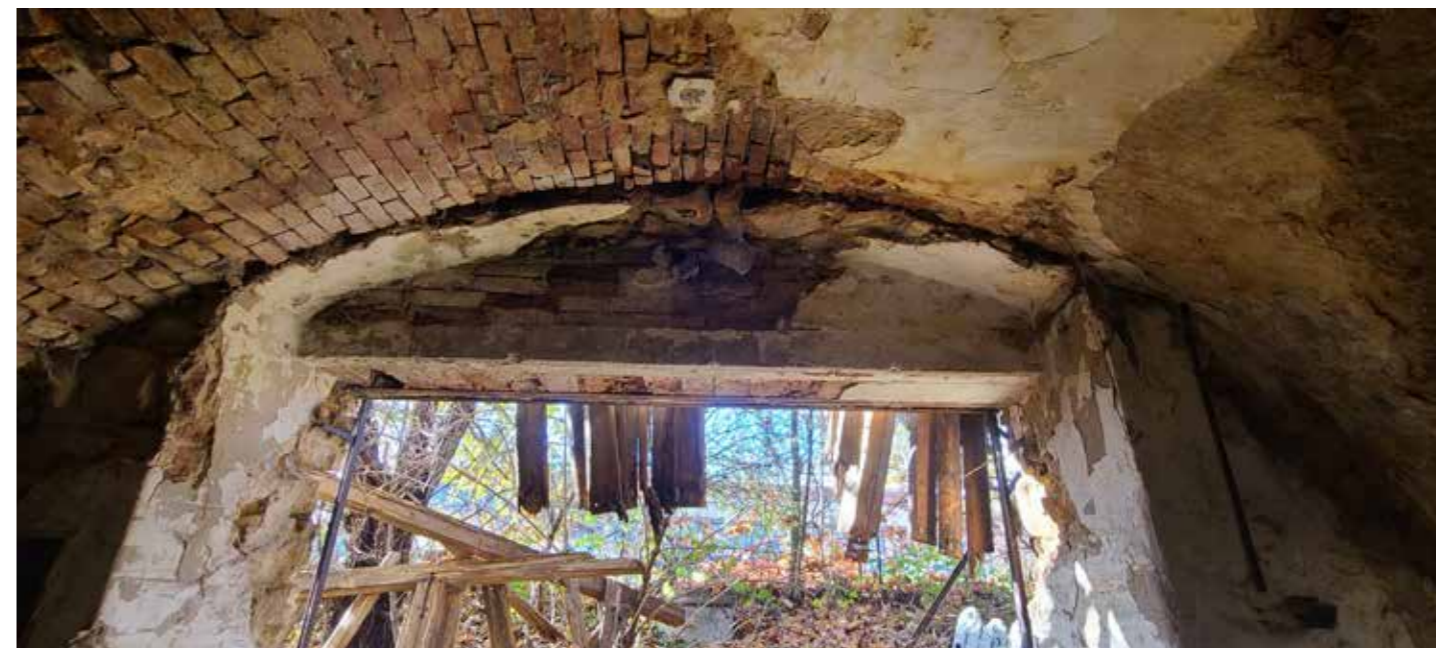
Pohled na klenutý vstup
