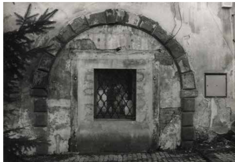
Bývalý průjezd objektu čp.15 severní fasáda
