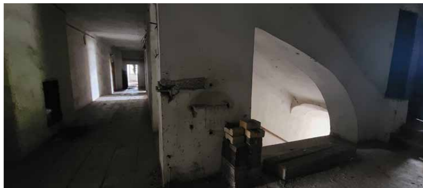
Chodba se schodištěm v prvním patře
