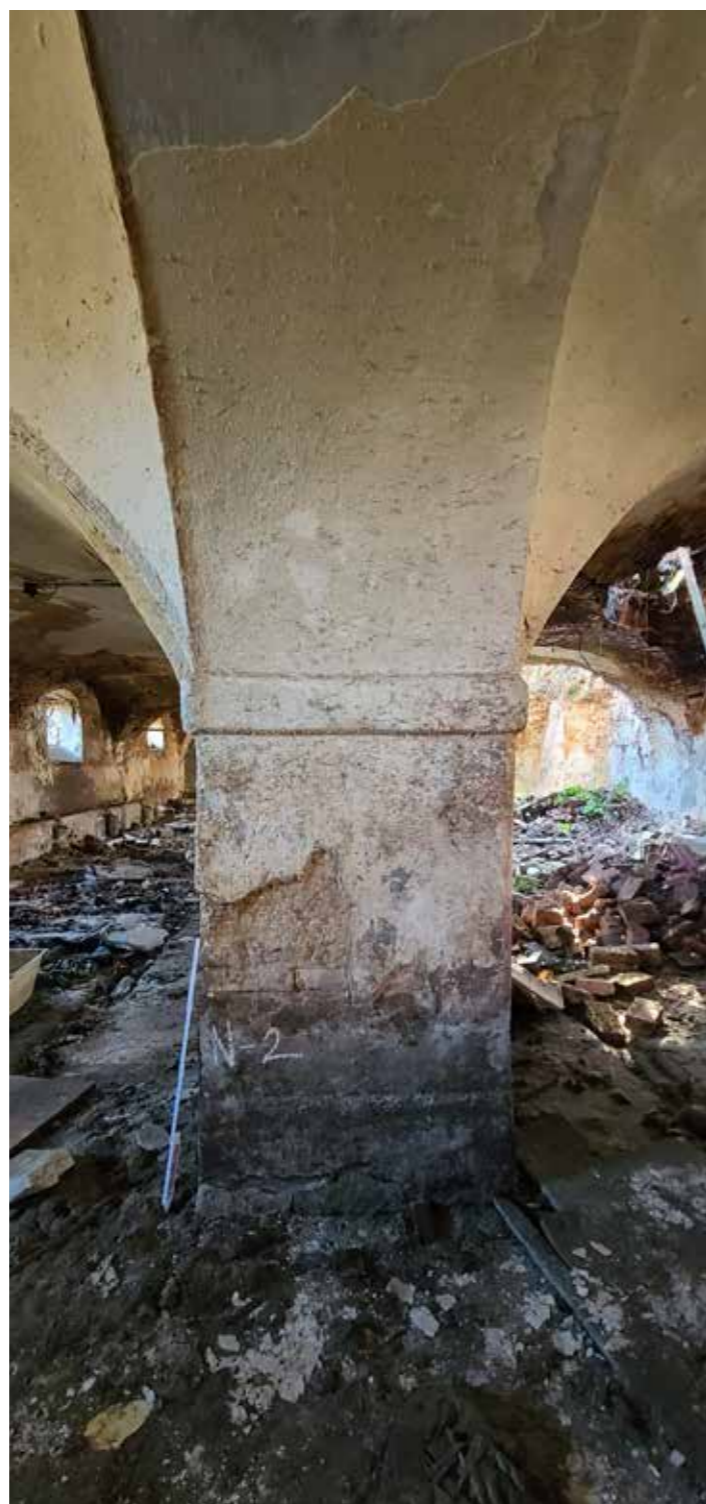
Omítnutý zděný sloup - klenební pas
