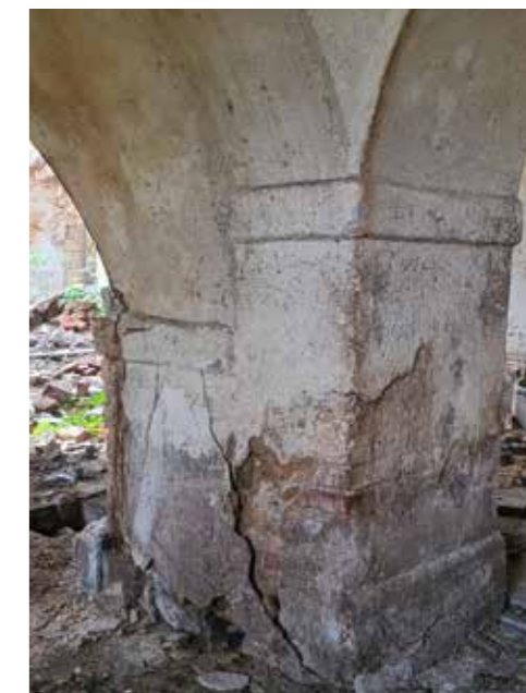
Pilíř přechodu křížové klenby na placku
