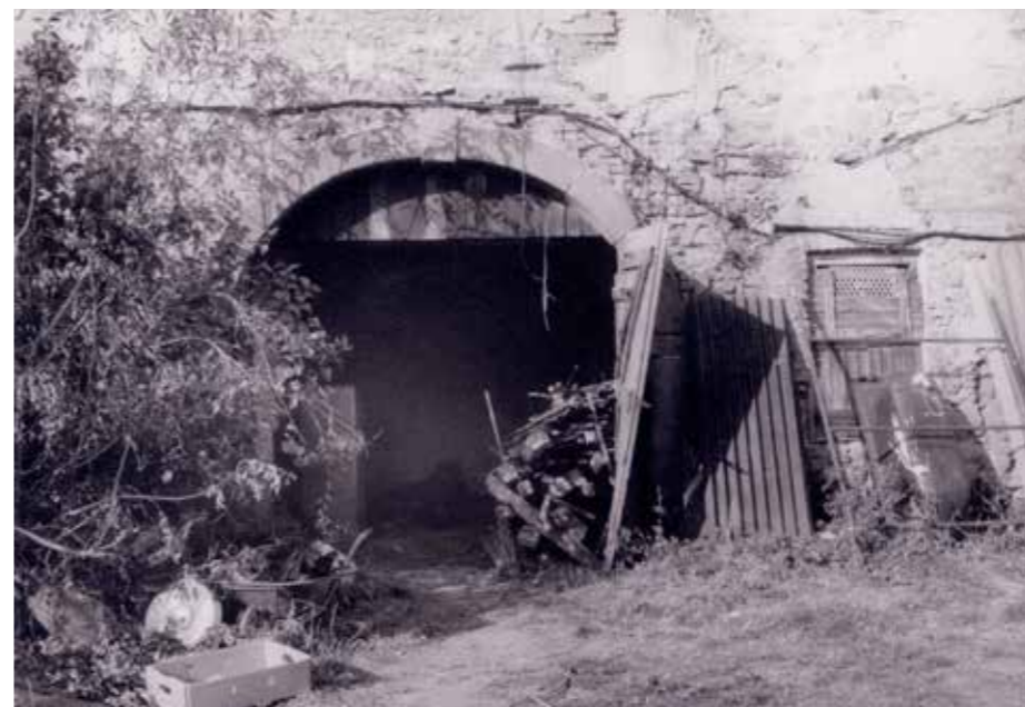
Bývalý průjezd objektu čp.15 jižní fasáda
