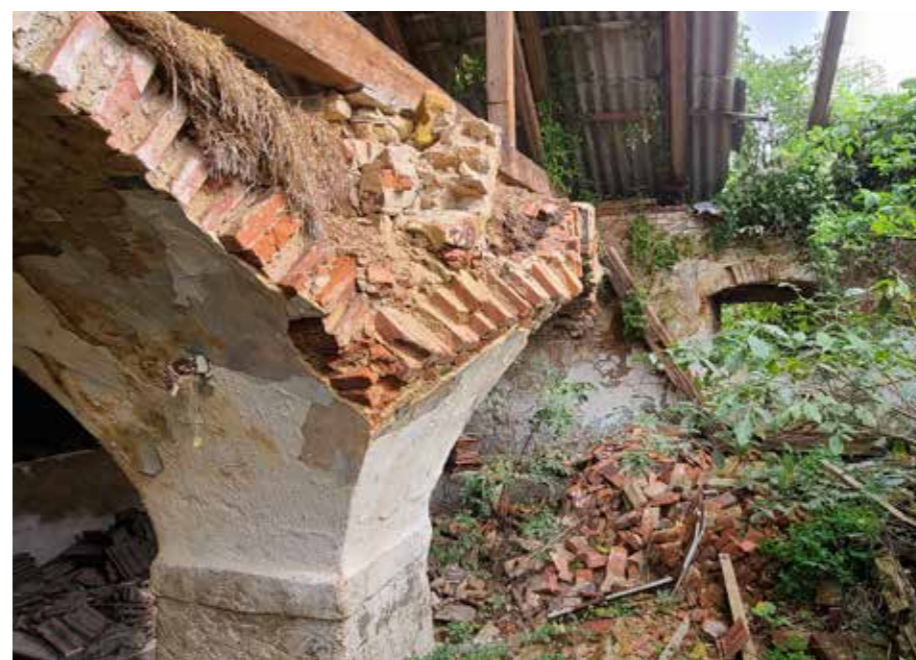
Přechod mezi zbořenou (jižní) a dochovanou (severní) částí objektu
