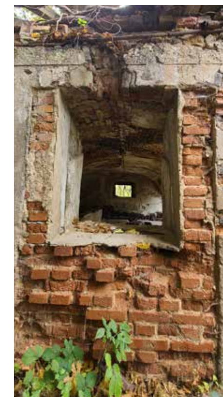
vyzdění okenního otvoru
