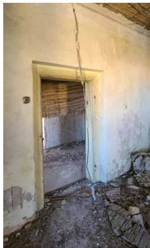
Pohled z pokoje na chodbu
