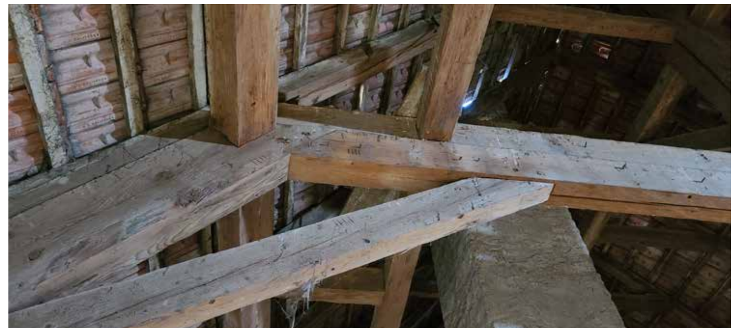
Detail plné vazby ležaté stolice s výměnou
