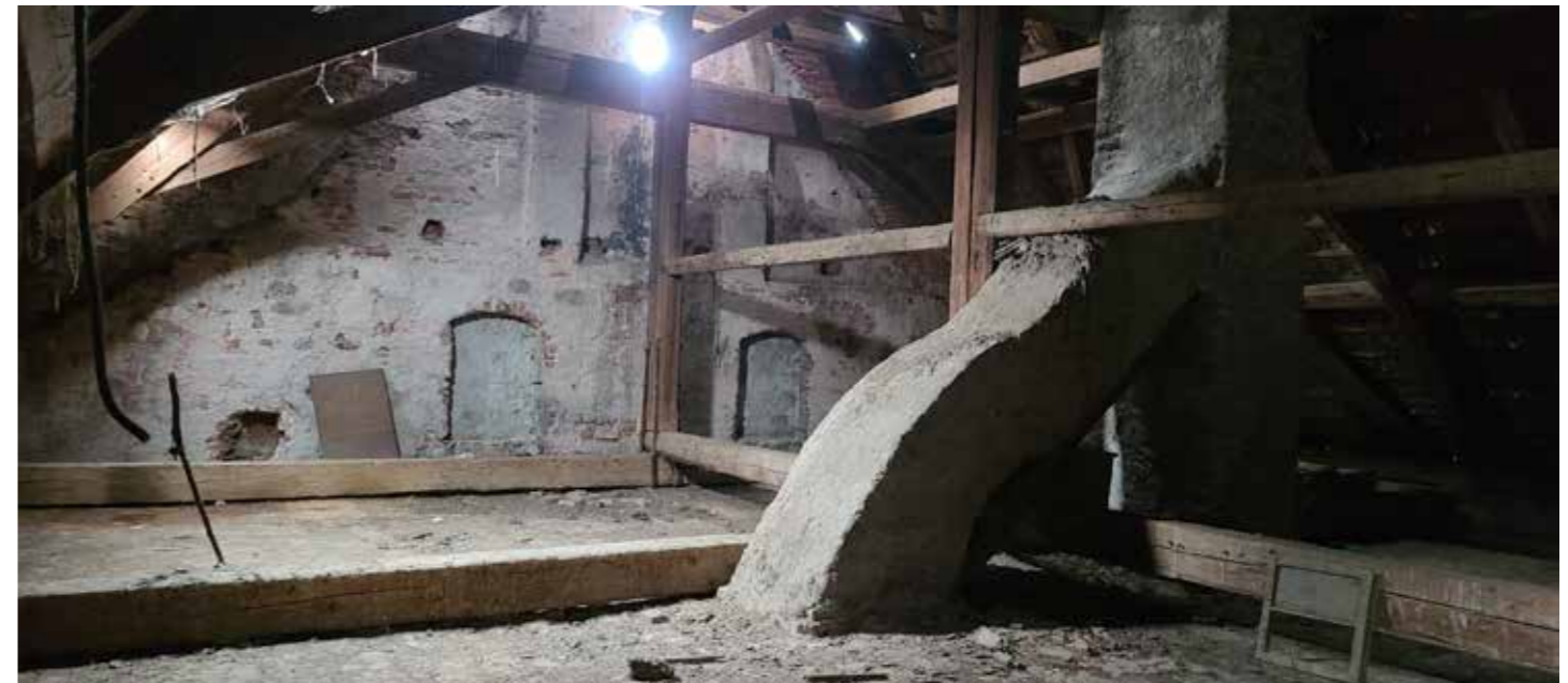
Detail spojení komínů
