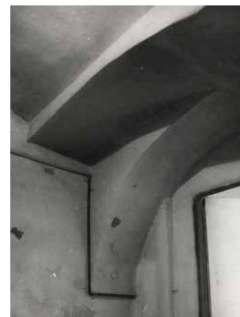
Interiér - pas zapuštěný do klenby 117
