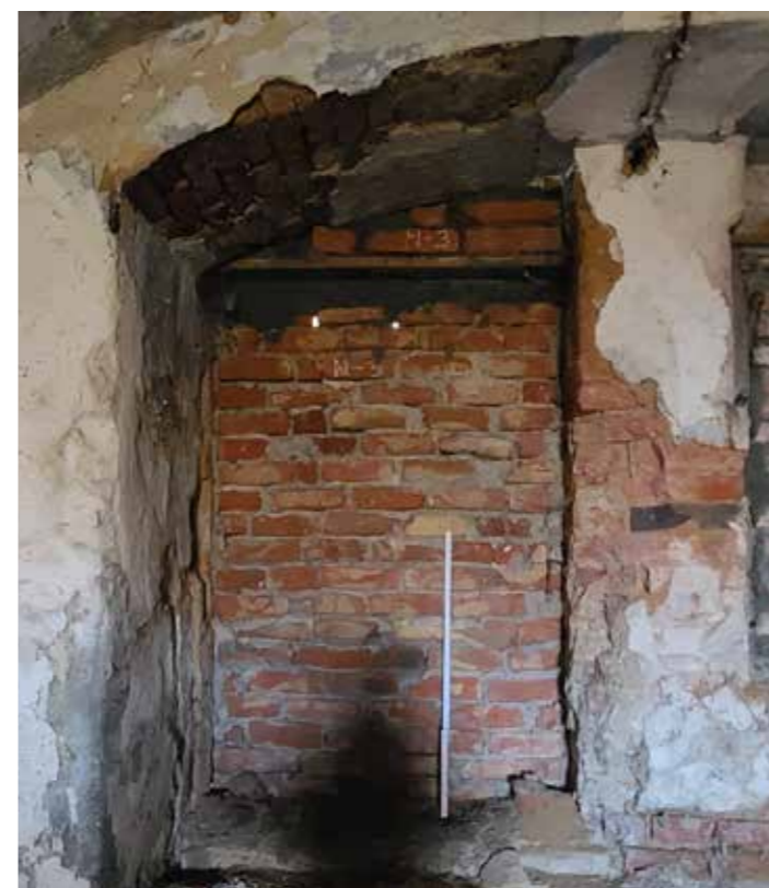
Pohled na zazděné dveře
