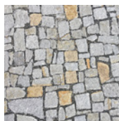
odseková žulová dlažba
