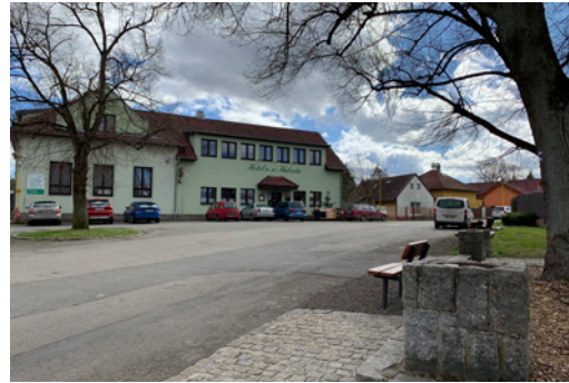
1 pohled přes Horní náves na budovu hostince
