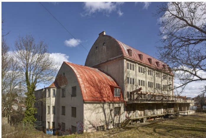
Silo Jihlava, Šlapal, 2023
