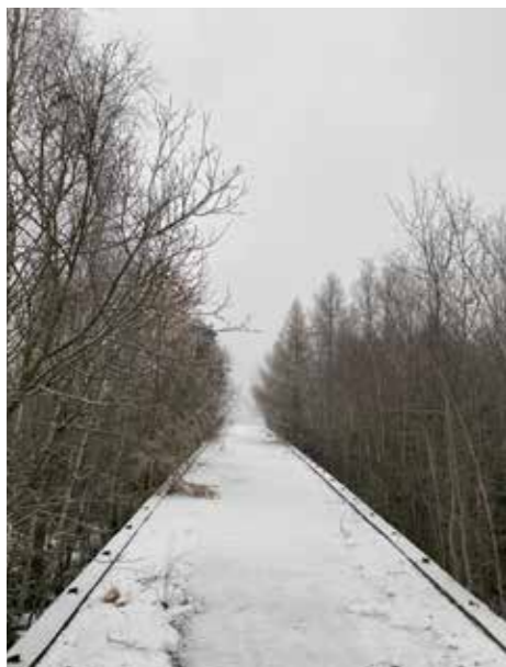
Rampa vedoucí na plošinu
