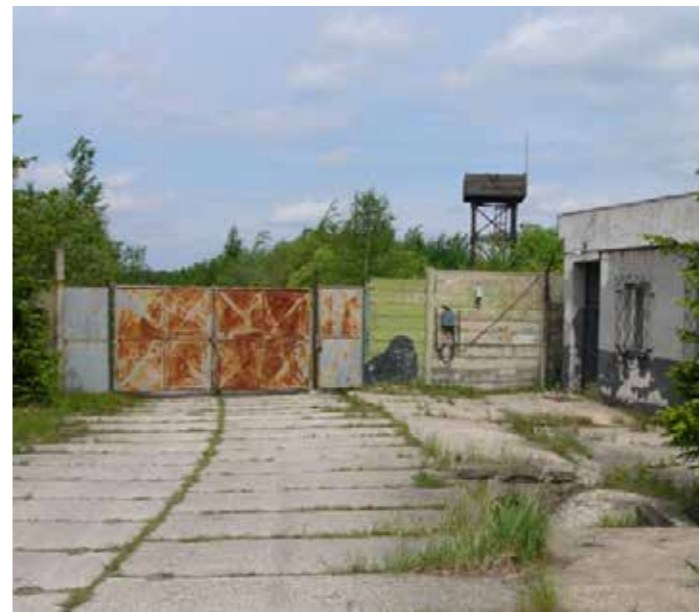
Vjezd do úseku „C“
