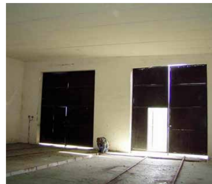
Zděný skladovací úkryt se uvnitř nijak nečlení
