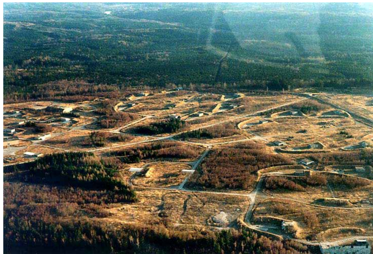
Úsek "C" uprostřed snímku palebná postavení oddílu (stav v roce 2000)
