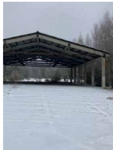
Přístřešek pro stání techniky
