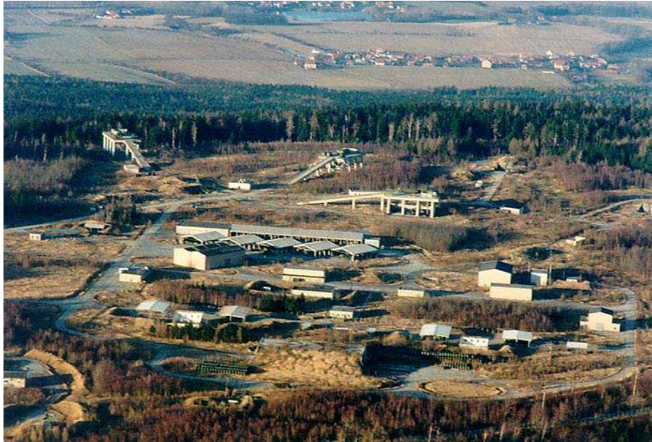
Úsek "C", uprostřed snímku budovy technického oddílu (stav v roce 2000)
