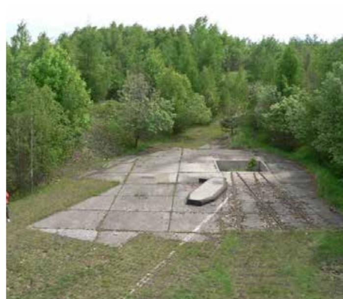
Pohled na odpalovací plochu ze stropnice těžkého úkrytu
