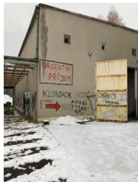
Budova zkušebny elektro instalace raket
