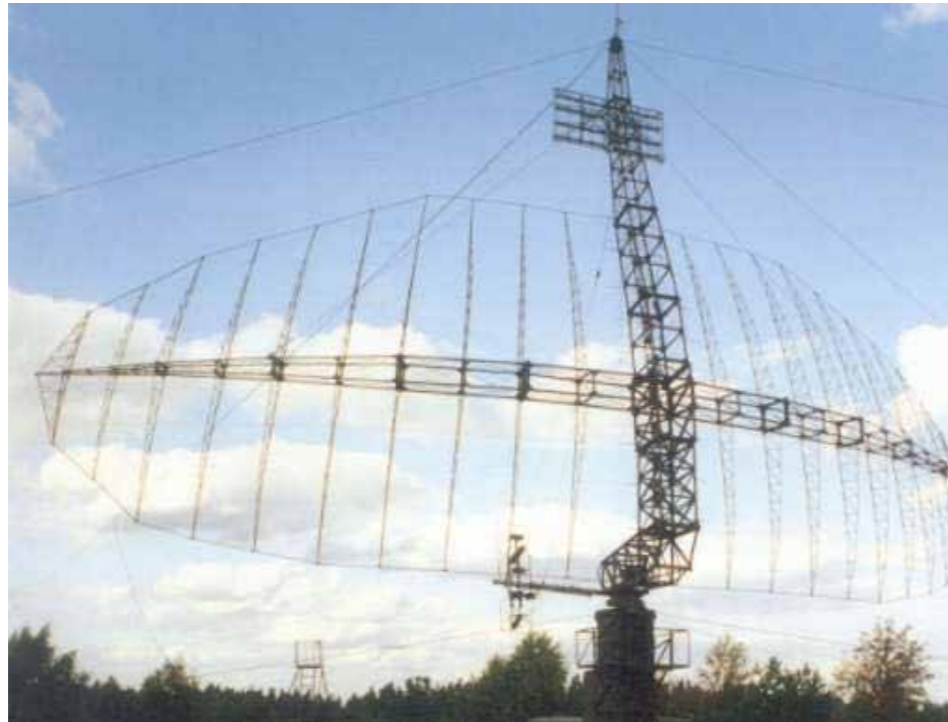
Anténa RL O-14 "Oborona" Na snímku jsou též rozeznatelné tři přístrojové kabiny AP-1, AP-2, AP-3 a anténa 1L22-1 "Parol"
