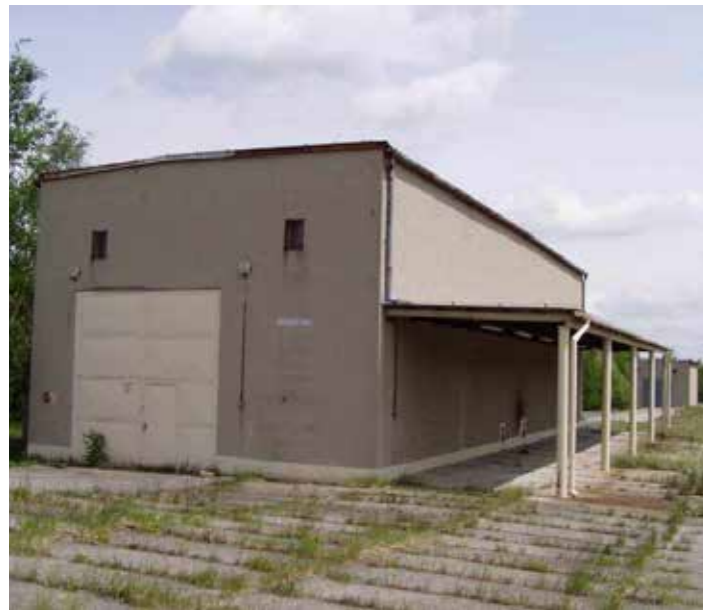
KIPS 5K43E (budova 22/24) - budova zkušebny
