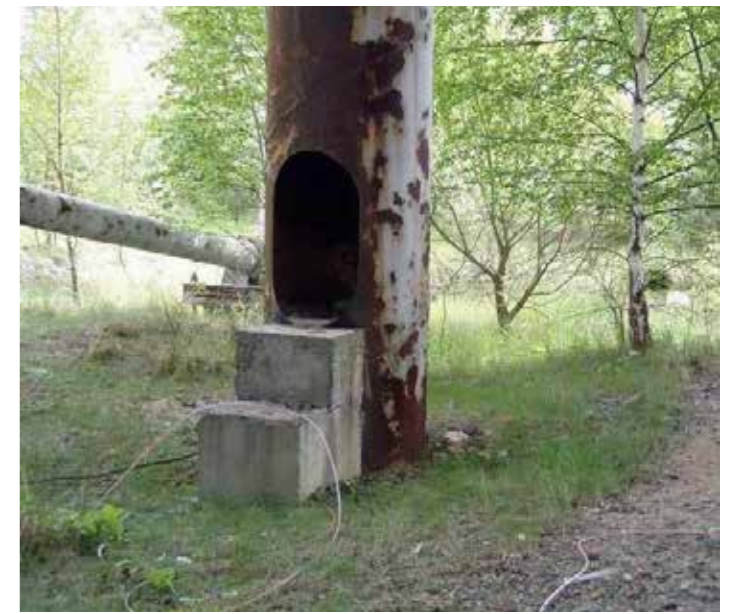
Revizní vstup do kabelové šachty
