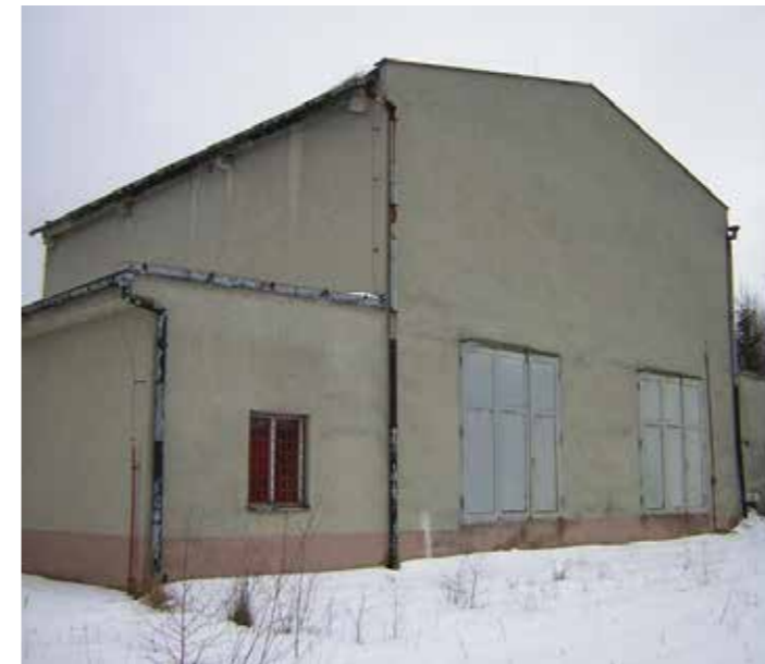
Budova TOS (zde se prováděly opravy raket)
