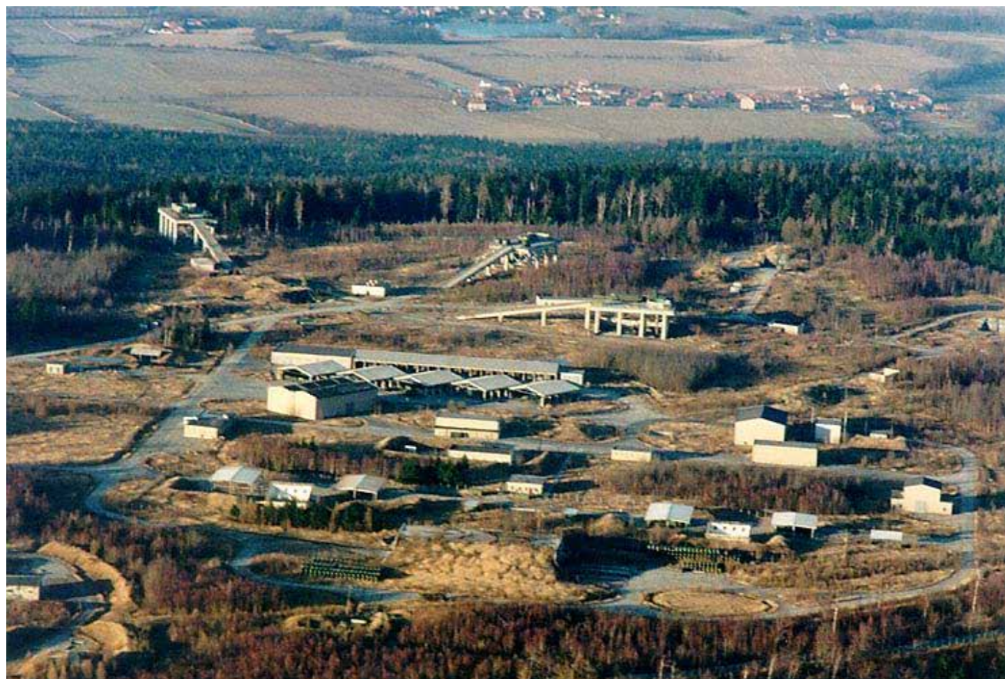
Úsek "C" uprostřed snímku budovy technického oddílu (stav v roce 2000) V popředí jsou ještě vidět skladovací bedny raket S-125 Něva
