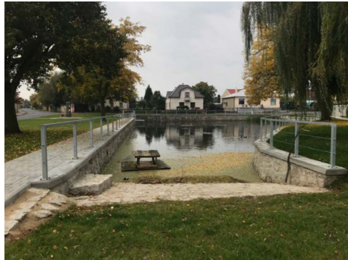
revitalizovaná vodní nádrž s ne zcela využitým potenciálem, obehnaná zábradlím působícím jako bariéra
