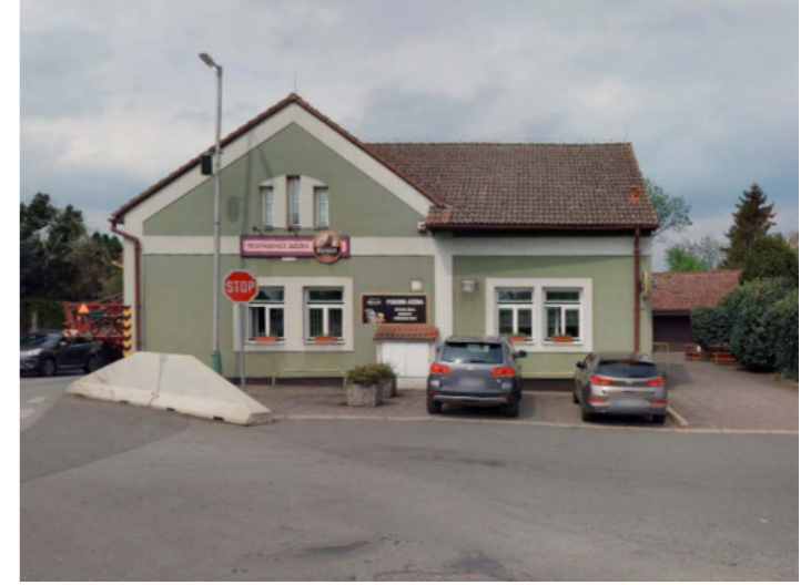
restaurace a penzion Jizera na návsi je hodnotou; problematický je předprostor sloužící pouze k parkování, s betonovou dopravní bariérou
