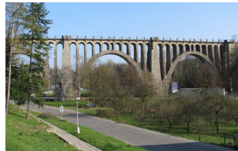
obr. Železniční viadukt (zdroj: pamatkovykatalog.cz, železniční most)
