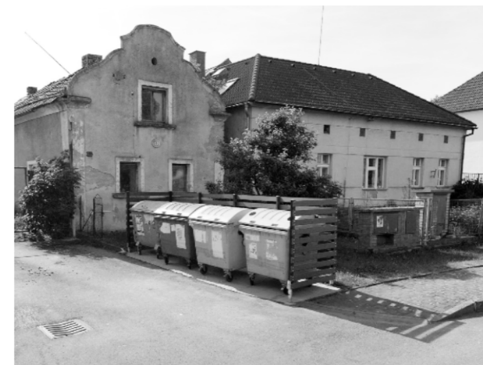
stávající umístění kontejnerů před průčelím historického domu na návsi
