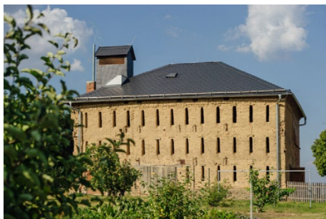
Obr. 16: Vesnická sušárna chmele v Odrlicích, Senice na Hané na Tršicku, 2. pol. 19.stol., jediná sušárna chmele z nepálených cihel v ČR
