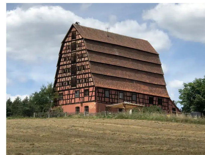
Obr. 18: Německá sušárna chmele nazývaná Hopfengut Mühlreisig z roku 1746 poblíž města Spalt
