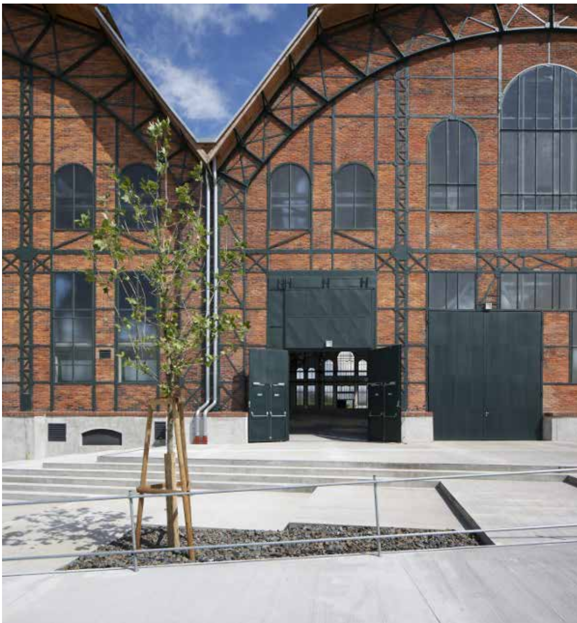
Ing. arch. Jiří Trčka, [online]. In: Časopis stavebnictví, [cit 8.11.2022]. Dostupné z: https://www.casopisstavebnictvi.cz/clanky-nova-karolina-ostrava-trojhalí.html
