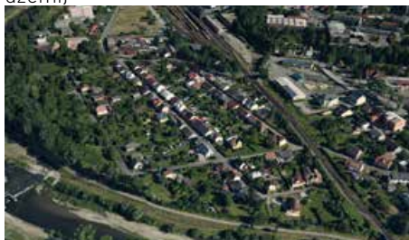
7 Rezidenční zástavba, Místek
