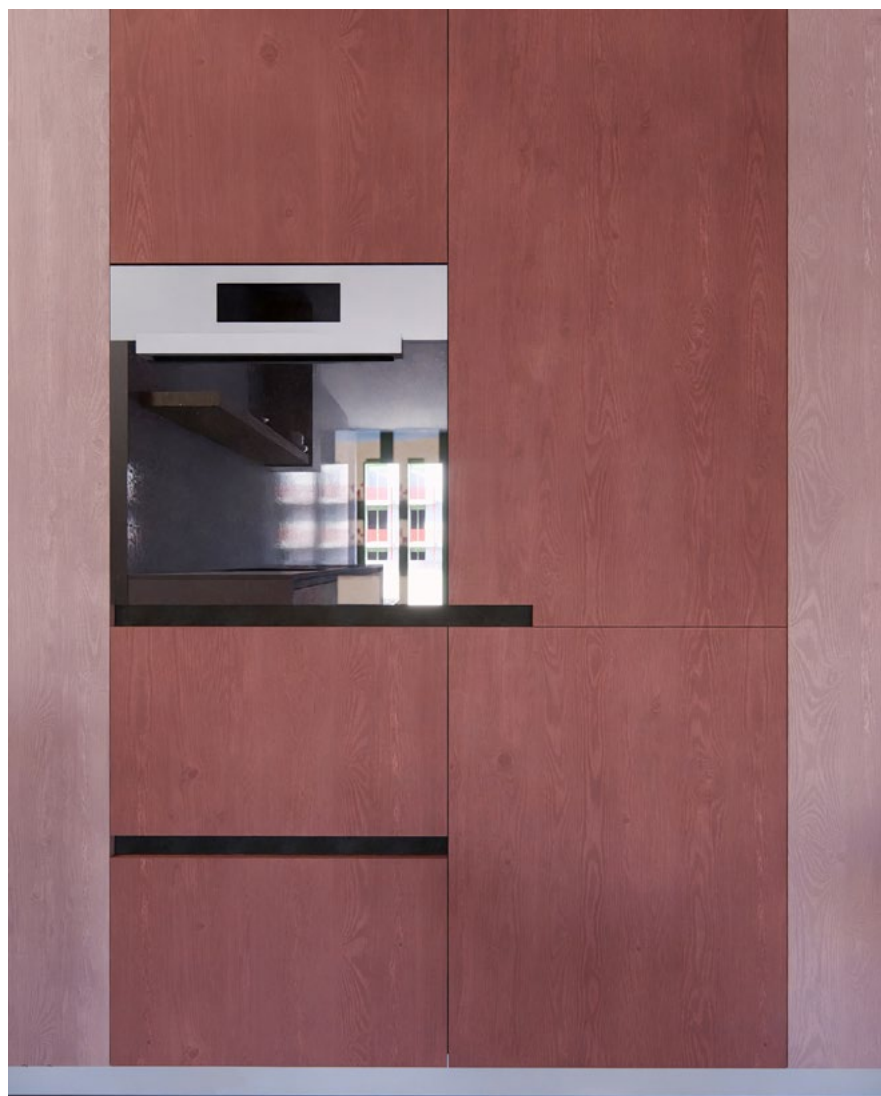
Detail řešení úchytů kuchyňské skříně a lednice
