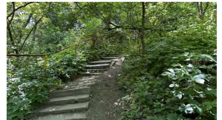
Šchody u potoka je ve špatném stavu (3)
