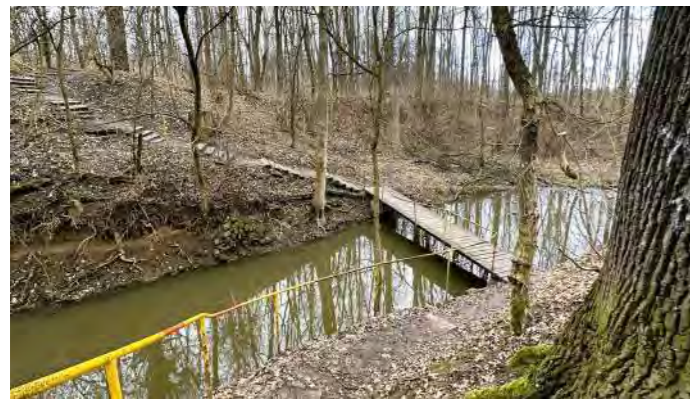
2. lávka a schody
