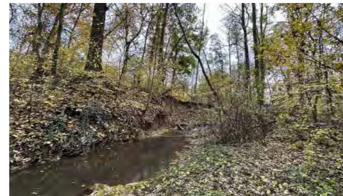
Eroze na březích
