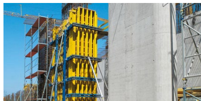
Obr. 19 – Sloupové bednění Tod 50 Zdroj: Sloupové bednění Tod 5l. [online]. Copyright © Doka GmbH 2022 [cit. 24.03.2023]. Dostupné z: https://www.doka.com/cz/system-groups/doka-wall-systems/column-formwork/top-50/index
