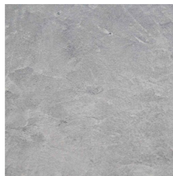
Za vstupními dveřmi_ Nášlapná vrstva podlahy je betonová stěrka. navrženo asfaltové souvrství.
