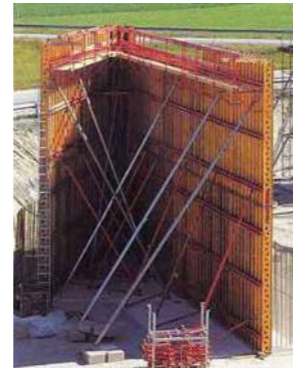
Nosníkové stěnové bednění VARIO GT 24
