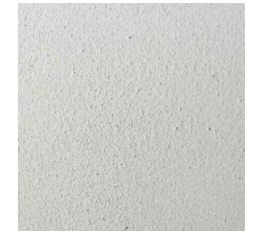
Povrchová úprava zdí vápenná omítka bílá
