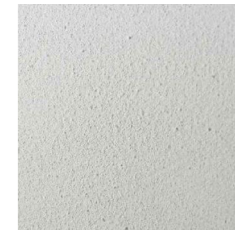
Povrchová úprava zdí vápenná omítka bílá
