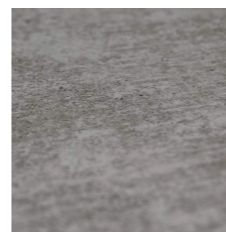
Betonová stěrka Kabefarben 1.12 šedá řasená úprava
