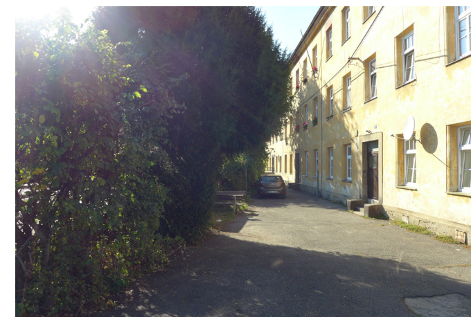
Prostor před bytovým domem.
