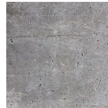
Beton - nosná konstrukce
