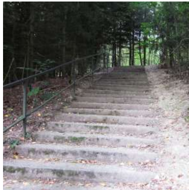
Obr. 24 Stávající kamenné schodiště vedoucí k jevišti přírodního amfiteátru
