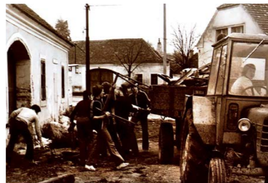
LX/ asi 1975, demolice starých domů
