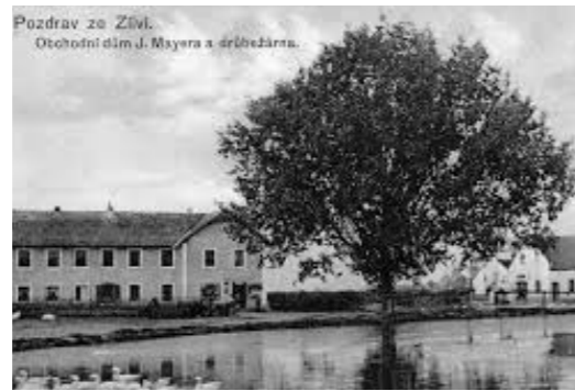
LI/ zlivská návés s ještě existujícím rybníkem
